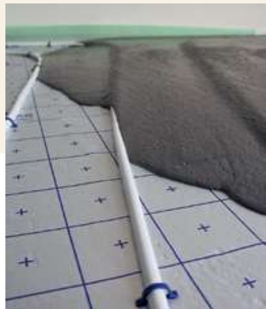
Gros plan sur une chape fluide avec chauffage au sol.
