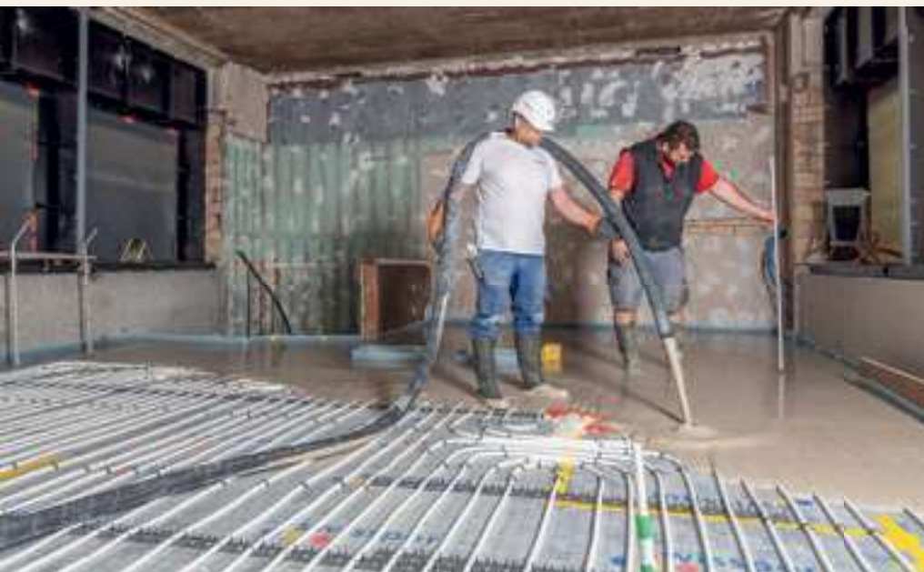
Installation d'une chape fluide en sulfate de calcium dans le cadre d'une rénovation.
