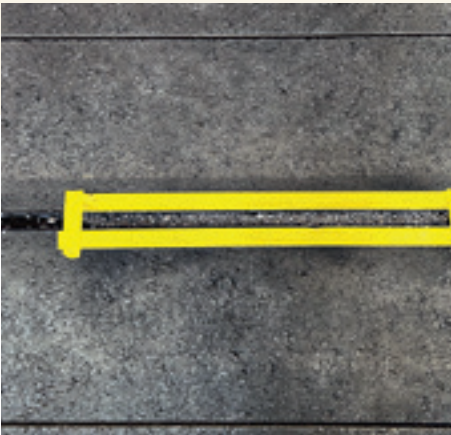
Einsatz von Unterfüllmaterial im Fugenverguss.
