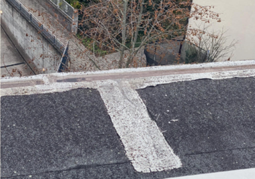
Flüssigkunststoff (FLK) auf Bitumen.
