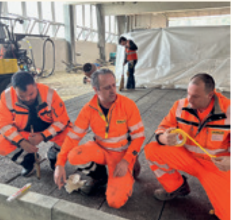
Die Fugen werden vermessen und grundiert.
