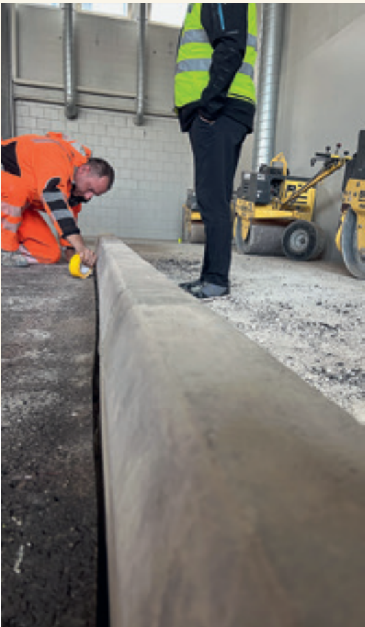
Die Fugen werden auf Trockenheit und Sauberkeit geprüft.
