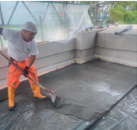
Mise en œuvre du mortier Planitop U-HPC.
