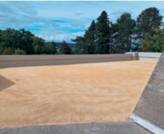
Surface rénovée terminée.
