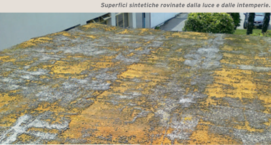
Synthetische Oberflächen, die durch Licht und Witterungseinflüsse beschädigt wurden.
