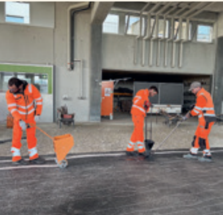
Verschiedene Fugengussverfahren wurden angewendet.
