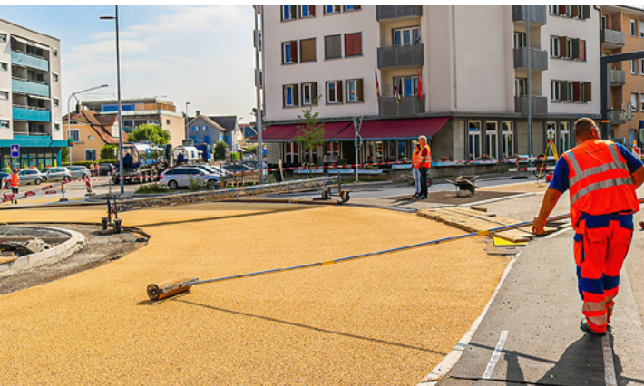
Nicht nur die Optik überzeugt: Der weisse Splitt reduziert die Hitzeentwicklung im Sommer und verbessert die Sichtbarkeit.
