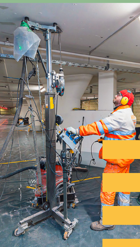
Die Schleierinjektion ist ein bewährtes Verfahren für die Sanierung von Feuchtigkeitsschäden in Betonmauern. (Bildquelle: Hydrojet AG)
