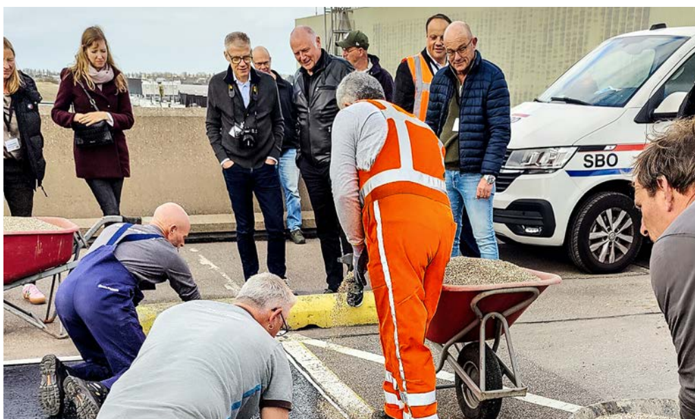
Die Baustellenbesichtigung beinhaltete die Renovation eines Parkdecks mittels Handeinbau.
