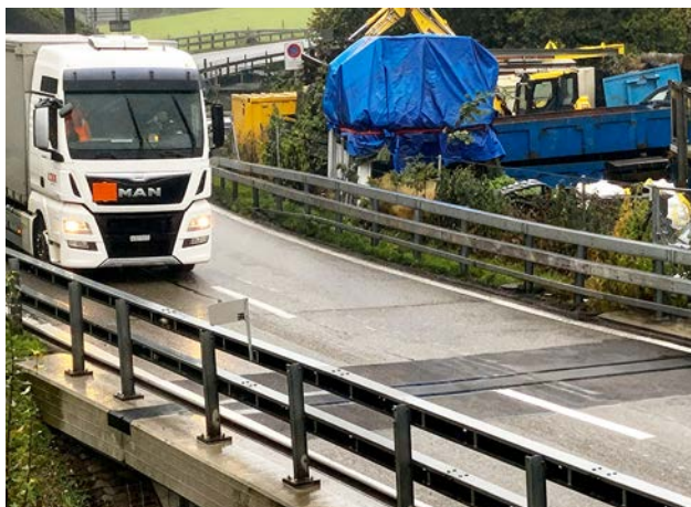
Fahrbahnübergänge zählen zu den am stärksten beanspruchten Bauteilen. Les joints de chaussée comptent parmi les éléments les plus sollicités.
