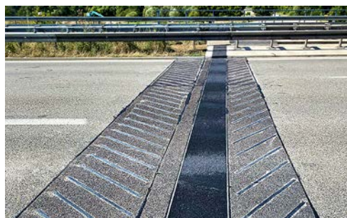
Gussasphalt-Deckschicht mit Stützrippen verstärkt. Couche de roulement en asphalte coulé renforcée par des nervures de soutien.
