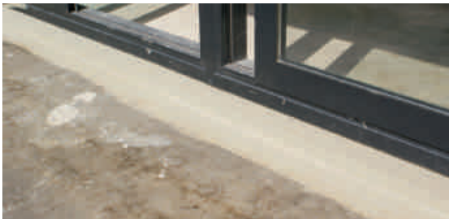
Abdichtung der Erdgeschoss-Fensterfronten mit ALSAN RS 274 (Grundierung) und ALSAN RS 230 thix (Abdichtungsharz für An- und Abschlüsse).
