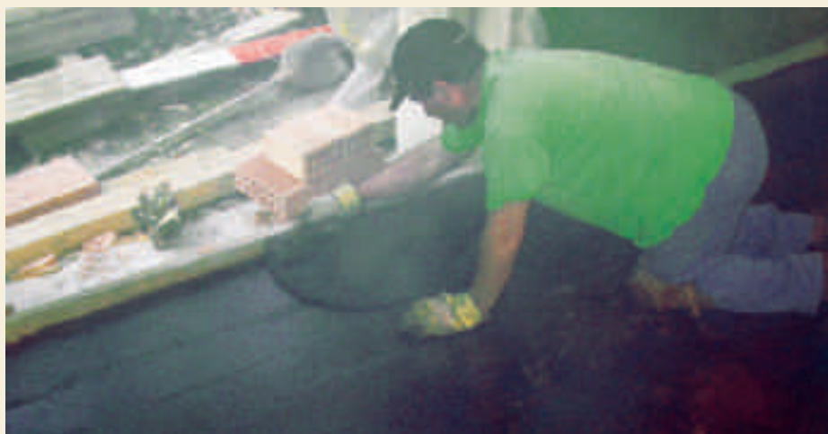
Les caves exposées au radon peuvent être étanchéifiées grâce à une chape en asphalte coulé.
