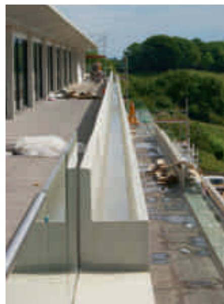
Die Blumentröge halten nach der Beschichtung mit ALSAN RS auch dem Kontakt mit Gartengeräten stand.
