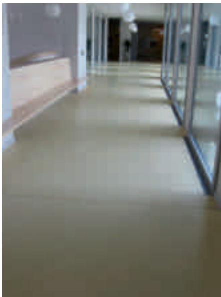
Fugen aus dem Untergrund werden im EUBOSTON-Magnesiafließbelag übernommen.
