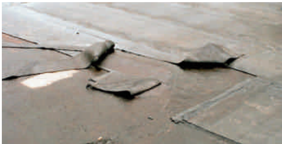
Abbildung 1: PBD-Abdichtung mit sehr schwachem Verbund. Direkt nach dem Aufblähen war der Verbund gut, am nächsten Tag jedoch völlig ungenügend.
