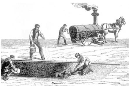
Arbeitsplatz für Gussasphalt mit Locomobil-Kessel im Jahre 1840.
