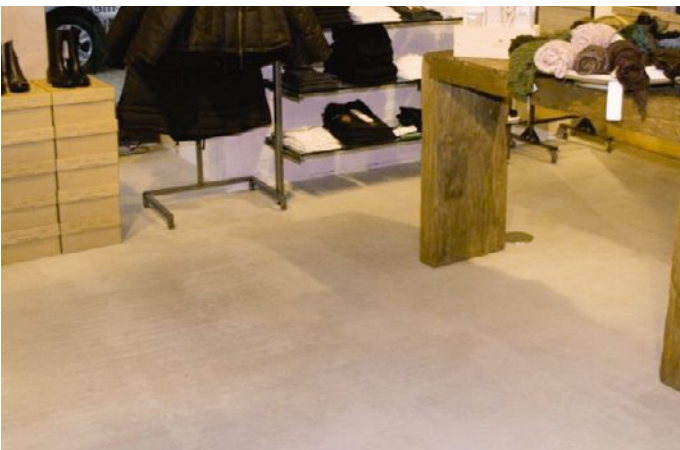
Fliessestriche sind als Fertigbelag im nichtindustriellen Bereich geeignet und werden direkt als ästhetisches Mittel eingesetzt.
