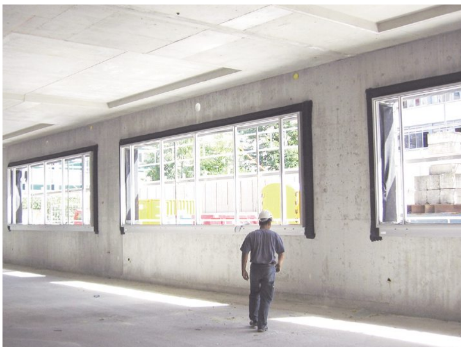
Freihängend verklebte Abdichtungsfolie (Membranfolie) im Innern.
