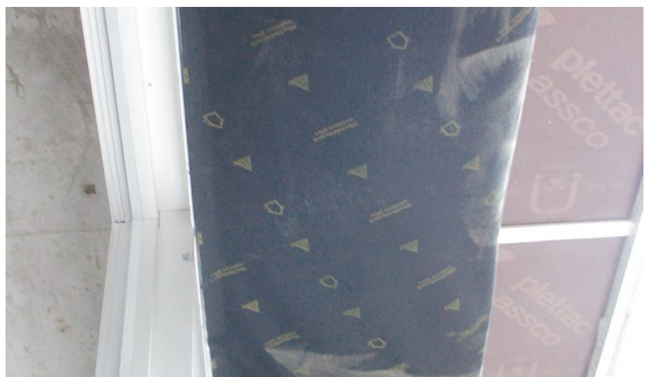
Freihängend verklebte Abdichtungsfolie (Membranfolie) aussen.
