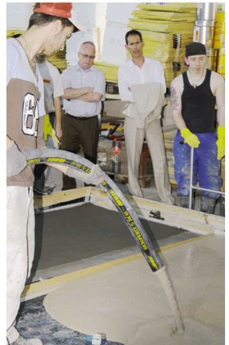
Demonstration des Fliessestrich-Einbaus mit Lernenden.
