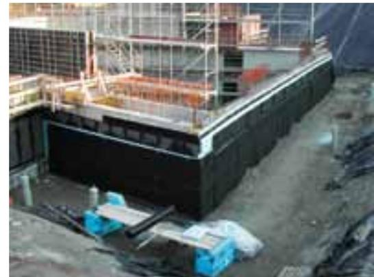
Die Kenntnis von inbegriffenen und nicht inbegriffenen Leistungen der Ausführungspositionen (hier Betonoberfläche, Abdichtung, Dämmung, Drainage und Schutzschicht), erleichtert dem Ersteller der Ausschreibung die Wahl der notwendigen Positionen und beschert weniger Ärger bei der Abrechnung.
