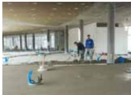
**Die neuen Zementestriche der Chemotechnik Abstatt GmbH können bereits 24 Stunden nach dem Einbau genutzt werden.**
