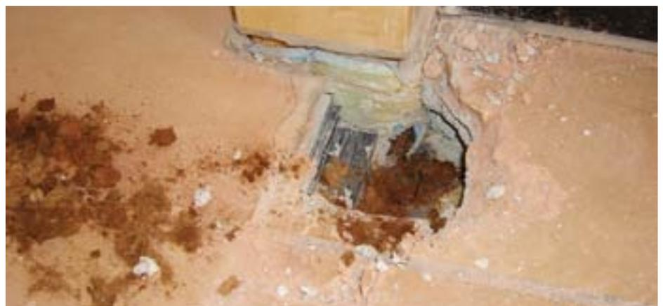
Abb. 4: Infolge Feuchtigkeit aufgelöste Dämmschicht. Die ursprüngliche Dämmschichtdicke von 80 mm ist auf rund 50 mm zusammengefallen.
