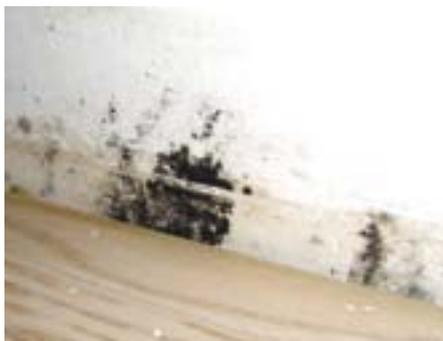
**Abb. 2: Schimmelbildung unter der Sockelleiste infolge unvollständiger Trocknung.**
