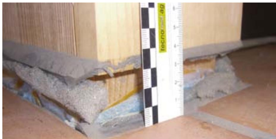
**Abb. 3: Extreme Absenkung infolge Zerstörung der Dämmschicht durch Feuchtigkeit.**
