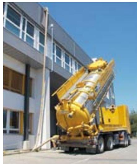
Das Entfernen und Wiederaufbringen der 12'000 m<sup>2</sup> grossen Kies- und Beschwerungsschicht geschah mit leistungsfähigem Saug- und Blasgerät in Etappen durch die Weiss+Appetito Spezialdienste AG in insgesamt nur vier Tagen.
