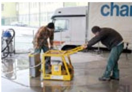
Der speziell modifizierte Rissfugenschneider im Einsatz.
