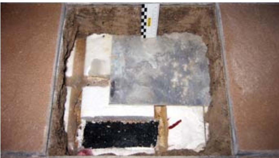
Abb. 1: Über Jahre vollständig durchfeuchteter Calciumsulfatestrich. In den Profilnuten der Dämmschicht sind noch die Spuren des Wassereintruchs sichtbar.
