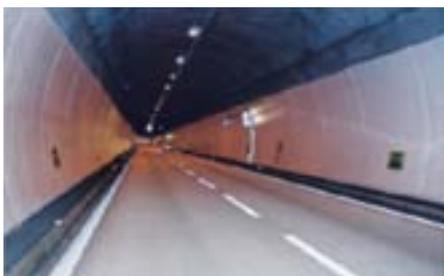
Mit einem hellen Fahrbelag im Tunnel lassen sich bis zu 40% Energie für Beleuchtung einsparen.
