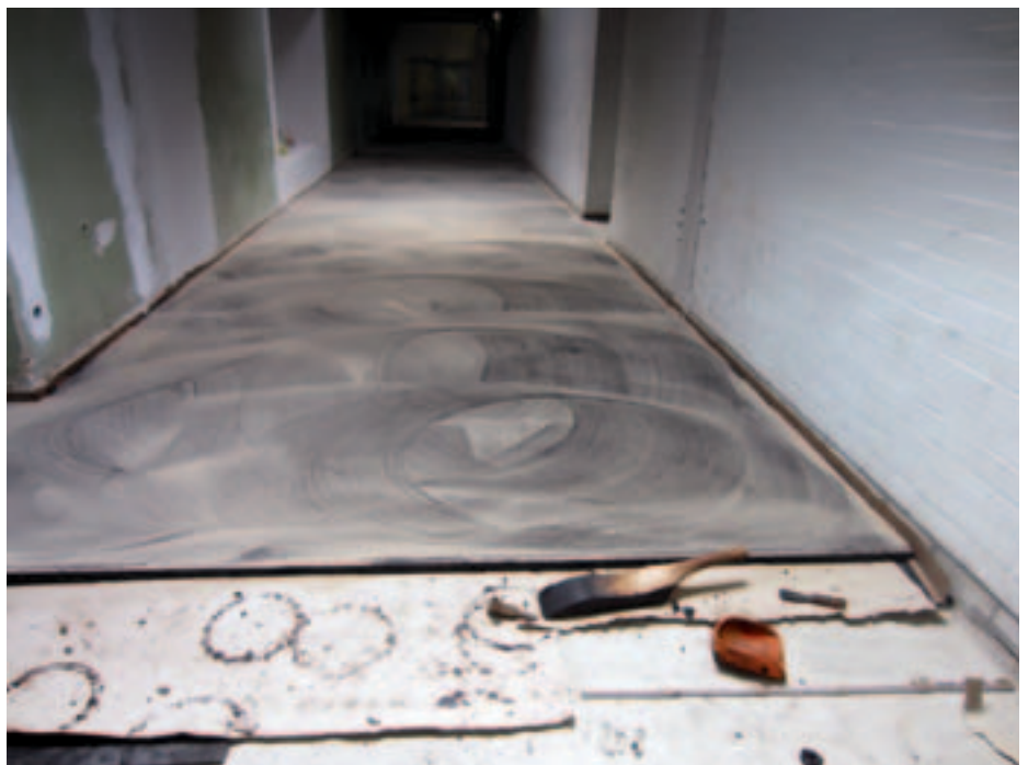
Extrem dünne Boden-Aufbauhöhe von weniger als 45 mm, inklusive Trittschalldämmung.
