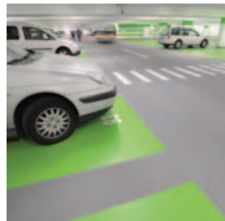
Vlieslose Abdichtung mit befahrbarer Fläche in einer Einstellhalle.
