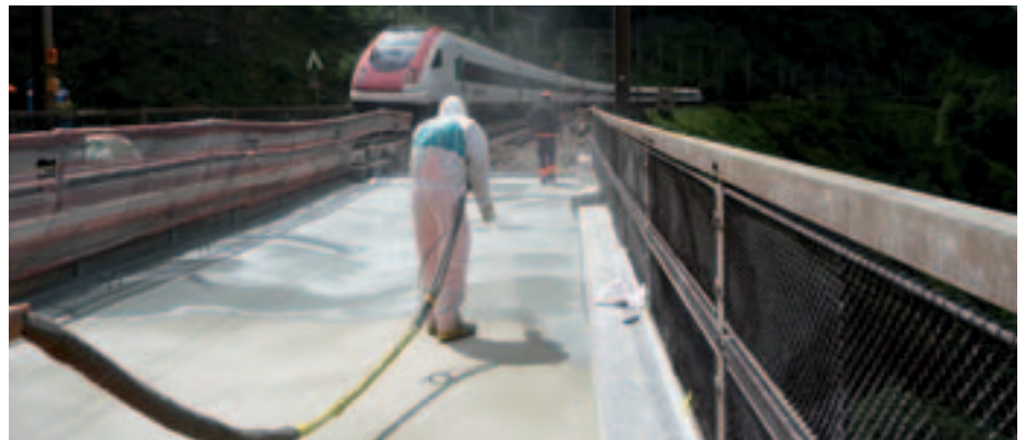
Erstmals wurde auf der Gotthardbahnstrecke für die Abdichtung eines sanierten Schottertroges hochreaktiver Flüssigkunststoff verwendet.
