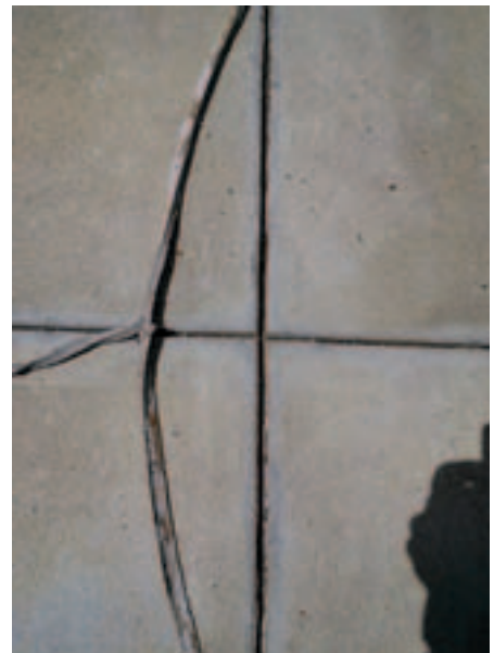
Was ist die Ursache des Versagens dieses Fugendichtstoffes?
