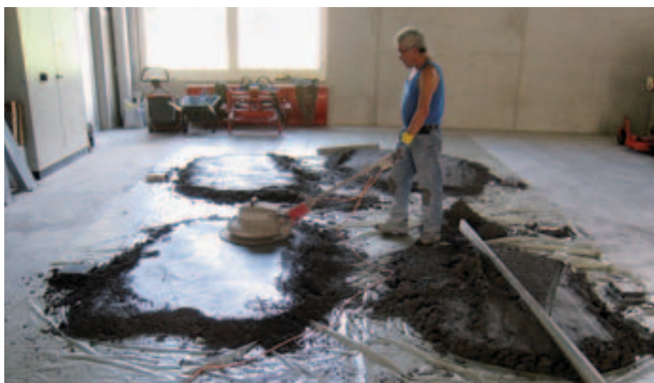
Herstellen des Estrichmörtels, verdichten und glätten.
