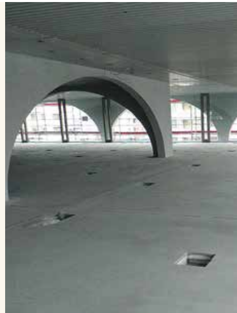
La technologie evo réduit le délai avant la pose du revêtement, ici dans un bâtiment à Landquart.
