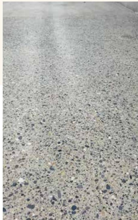
Geschliffener Beton mit Recycling-Kies
