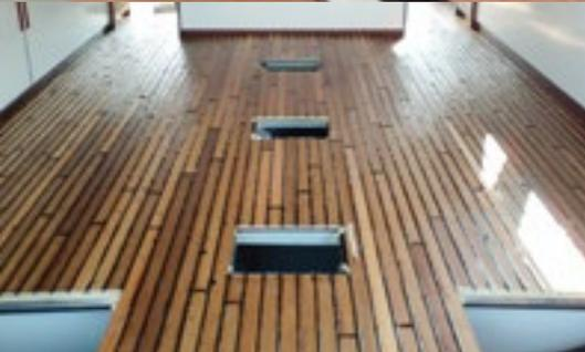
**oben:** Die Fugen wurden mit einem speziellen Dichtstoff verfüllt und überfüllt, dann abgestossen und abgeschliffen. Die plane Oberfläche wurde schliesslich geölt.
