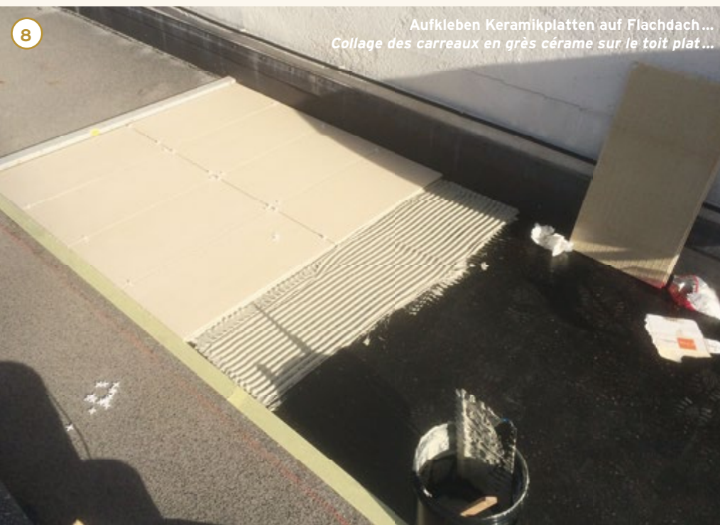
6 Verlegen Keramikplatten mit Zahnspachtel. Pose des carreaux en grès cérame à l'aide d'une spatule crantée.
