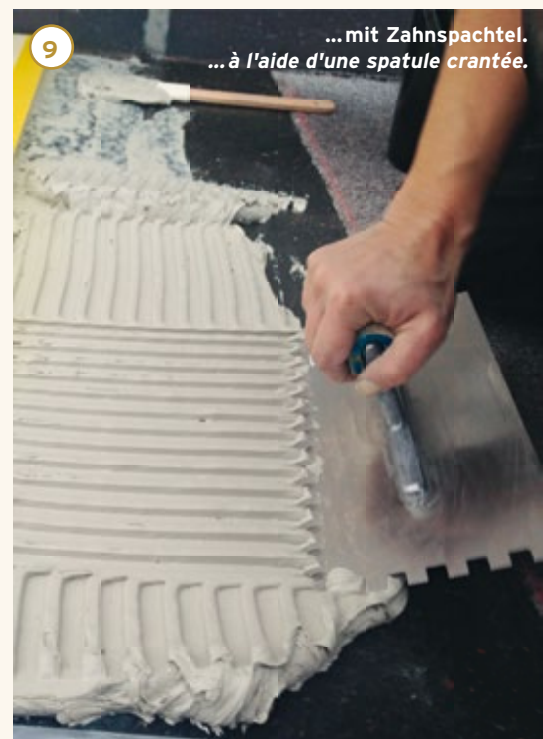
8 Aufkleben Keramikplatten auf Flachdach... Collage des carreaux en grès cérame sur le toit plat...
