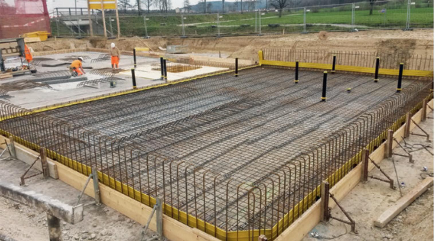
Das Fehlen zusätzlicher Abdichtungsschichten hat Vorteile in der Terminplanung, da die WDB und die zugehörigen Abdichtungsmassnahmen bereits während oder kurz nach dem Betonievorgang ausgeführt werden.
