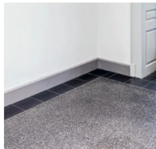
Bei der Gestaltung der Gussasphaltbeläge hat man sich an den Bestandsflächen orientiert. Im Kellergeschoss wurde daher ein schwarzer, gewalzter Glanzasphalt eingebaut.
