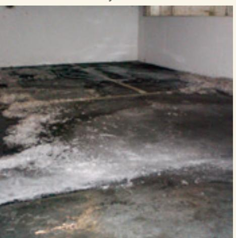
De l'eau qui pénètre à travers des endroits non étanches et qui gèle à l'intérieur du bâtiment suite aux températures basses.
