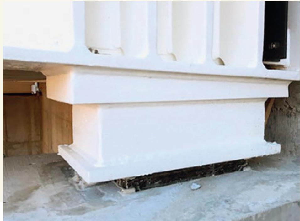
Brückenlager, beweglich in Längsrichtung.
