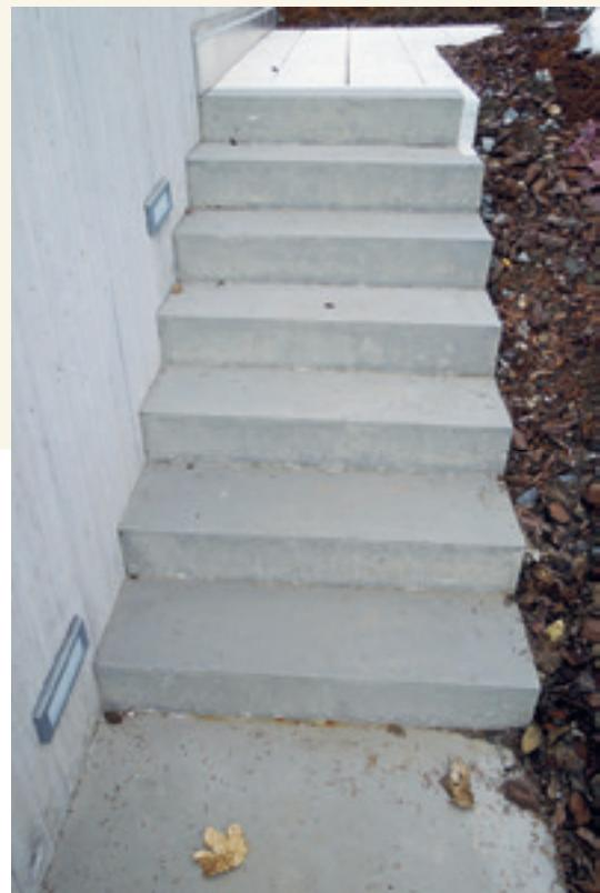
Für die Sanierung wurde die aussenliegende Betontreppe mit PCI Aposan instandgesetzt.
