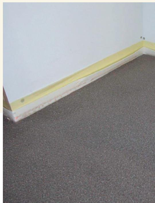
Abschluss der Estrichkanten mit einem gut verlegten Randstreifen.
