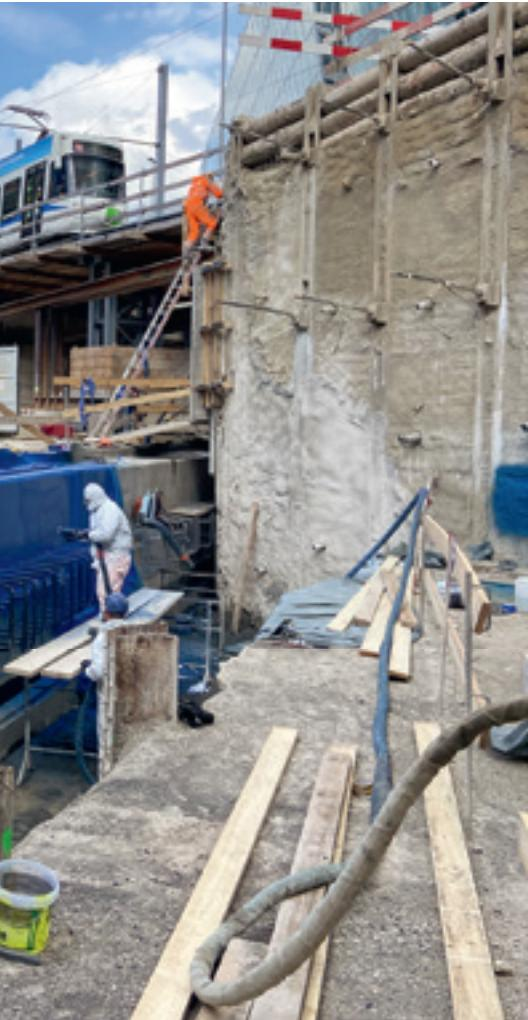
Le raccord de l'étanchéité de la nouvelle construction avec les ouvrages existants - le tunnel des CFF et The Circle - constitue un défi supplémentaire. Pour que cette réalisation soit possible, les détails et les matériaux utilisés ont dû faire l'objet d'une planification approfondie.
