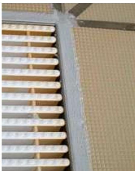
Fugen in öffentlichen Duschanlagen werden stark beansprucht und sind Wartungsfugen.
