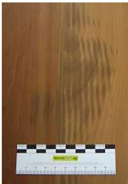
Selbst am Parkettbelag können dunkle Verfärbungen infolge Zersetzung der Bindemittel von Mineraldämmstoffen oder der Leimschichten von Kaschierungen durch Feuchtigkeitseinwirkung auftreten.
