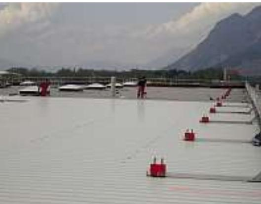
**Selbstklebebahnen können die Einbauzeit von Flachdachabdichtungen wesentlich verkürzen. Auf der Apco-Halle wurde eine zudem rissfest konzipierte Dampfbremse (Sopravap Alu Stick ts) direkt und «kalt» auf die Profilblech-Unterkonstruktion geklebt.**
