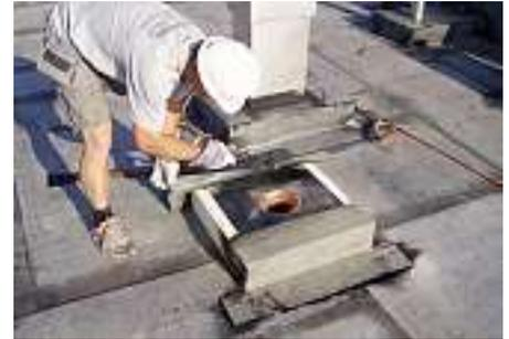
Das sichere Abschotten von Anschlüssen und Einläufen gegenüber Abdichtungsflächen gehört zur Standardausführung nach neuer SIA Norm 271: 2007.
