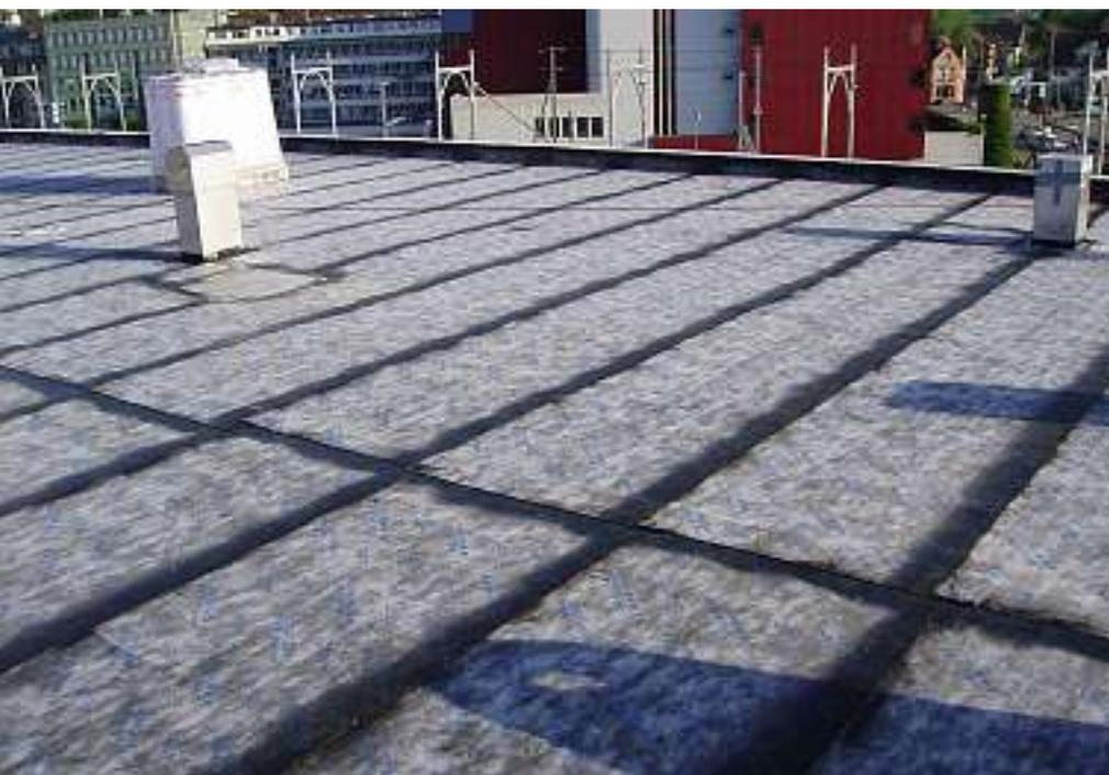
Lose und auf diese Weise schnell verlegbare Unterlagsbahnen wie swissporBIKUTOP LL Vario v erhöhen die Einbaueffizienz bei Flachdachisolationen.
