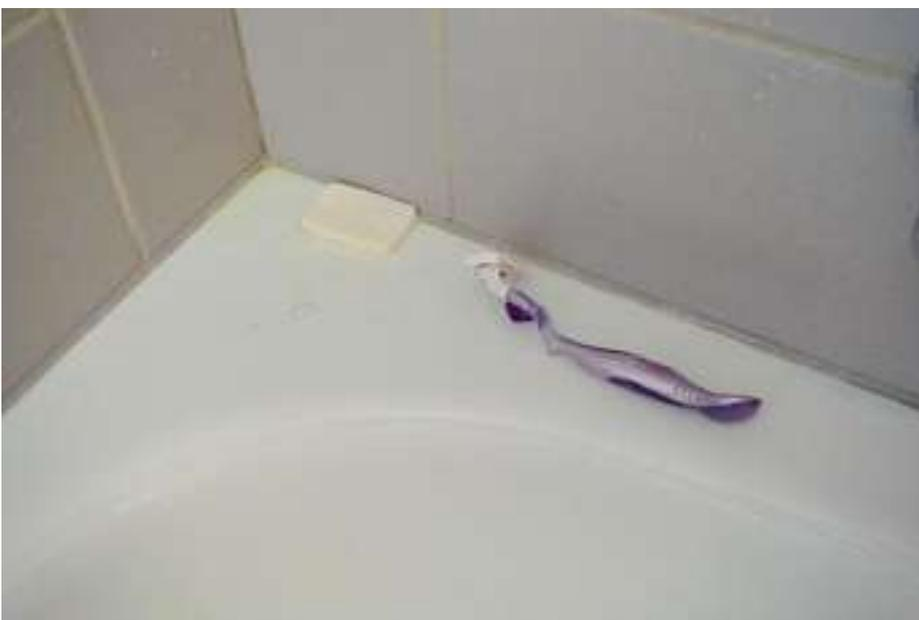
**Nicht alle Fugen sind Wartungsfugen: Ausschlaggebend ist das Mass an Einwirkung von Feuchtigkeit, Wärme, Reinigungsart und Art der Desinfektionsmittel.**
