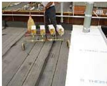
**Nach dem Aufbringen von PUR-Klebestreifen auf die Dampfbremse wird die Wärmedämmung aufgeklebt und so windfest eingebaut.**
