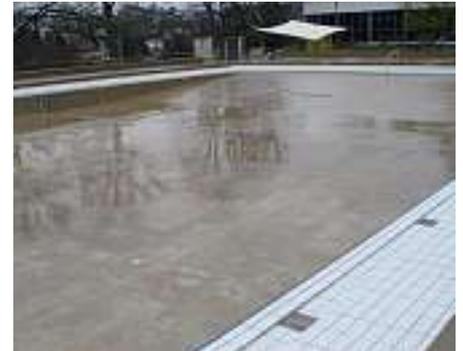
**Mit Dichtstoffen ausgebildete Fugen in Schwimmbädern gelten als typische Wartungsfugen.**
