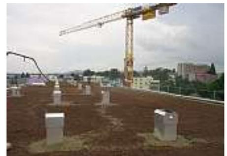
Zur Begrünung des Daches wurde eine 10 cm starke Substratlage aufgebracht.
