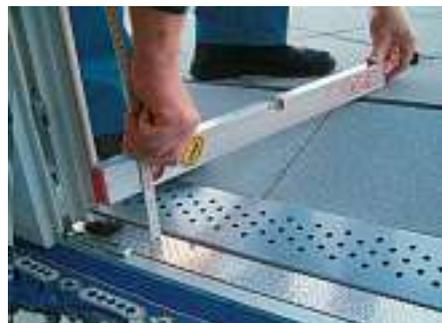
**Der Wunsch nach «schwellenlosen» Terrassentüren wird häufig angebracht. Hier zu sehen: Ein «versenkter» Türschwelleranschluss.**
