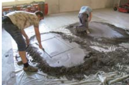
Die Probefläche wird z.B. mit dem Fugeneisen markiert und «ausgeschnitten».
