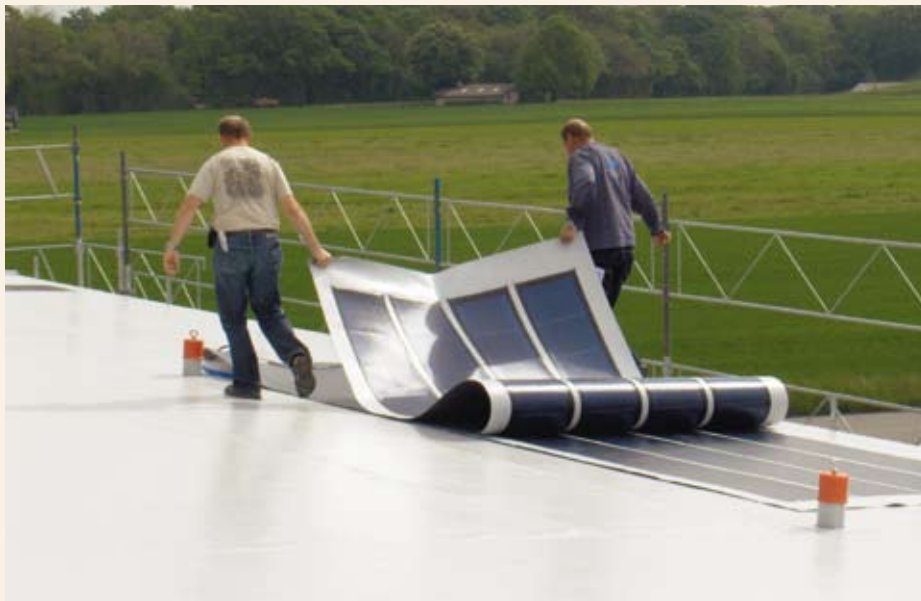
Mise en œuvre des laminés photovoltaïques.
