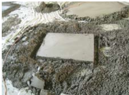
Korrekt hergestellte Probefläche in der erforderlichen Dicke.
