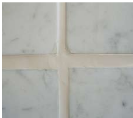
Die Wahl des richtigen Dichtstoffes (meistens Produkte auf Basis eines neutralvernetzenden Silikons) verhindert Auswanderungen bei Fugenabdichtungen im Natursteinbereich.
