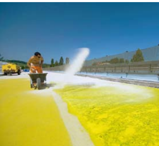
Auf die erste Lage Reaktionsharz wird Quarzsand abgestreut.
