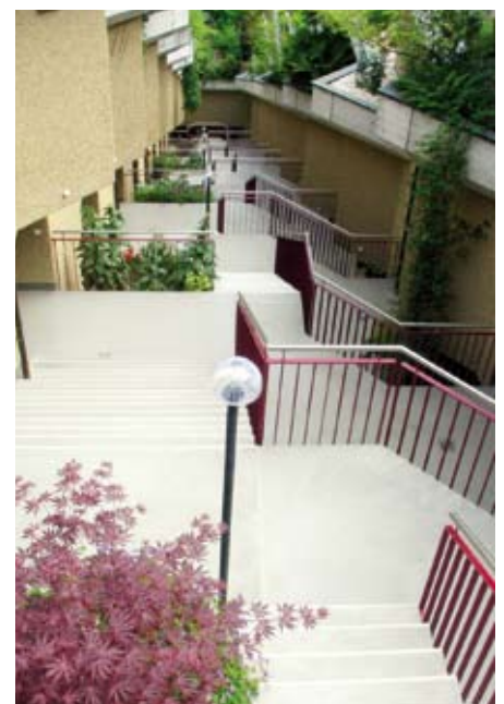
Die dauerhaften PMMA-Flüssigkunststoff-Beschichtungen eignen sich optimal zur Sanierung von Oberflächen und Belägen (Treppenanlage nach der Sanierung).
