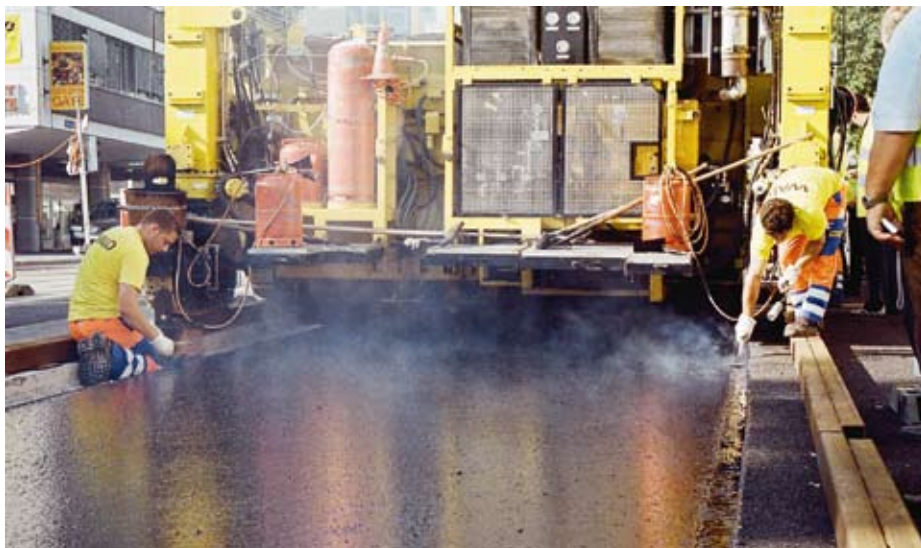
In der Schweiz gang und gäbe, in vielen anderen europäischen Staaten aber wenig bekannt: Maschinelles Gussasphalt-Einbau am Beispiel einer Binderschicht mit einem Gussasphalt MA 16 H PmB mit Trinidad.
