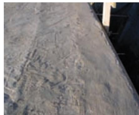
**Ausgleichsschicht wurde teilweise und ohne vorgängige Reinigung aufgetragen. Oberfläche ist zu uneben. Nachbearbeitung mit Oberflächenfräse.**
