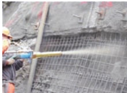
Mit einer Förderleistung von bis zu 7 m<sup>3</sup>/h und dem wirkungsvollen Zusammenspiel der Zuführung von Beton, Schnellbinder und Druckluft können selbst Wandtiefen bis 30 cm einfach und schnell aufgefüllt werden.
