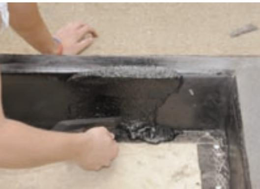
In England wird Gussasphalt (Mastix-Asphalt) auch für Aufbordungen - zum Beispiel auf dem Flachdach - angewendet...
