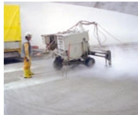
**Hier musste mit größerem Geschütz aufgefahren werden: Wasser-Hochdruckstrahlen mit 2000 bar, Abtragung 2-3 mm.**
