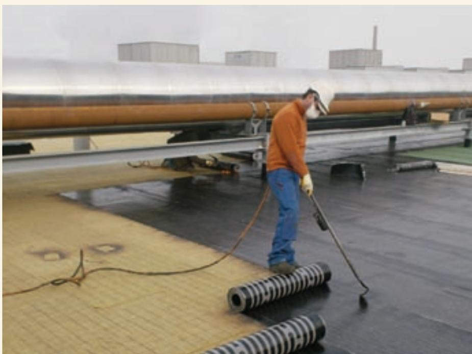
Soudage de la première couche de lés d'étanchéité en bitume polymère.
