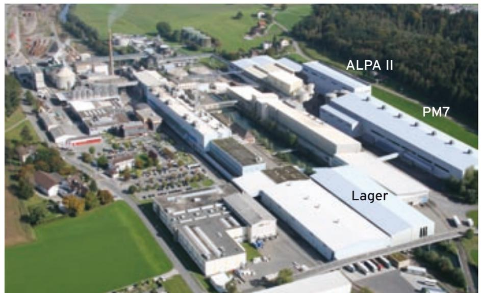
Übersicht Perlen: PM7-Halle mit vorgelagerter Altpapieraufbereitung ALPA II sowie erweiterter Lagerkapazität.
