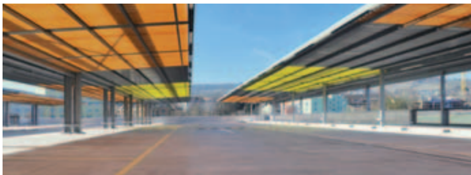
Bild 4: Nachhaltige Sicherheit: Parkdeck mit hochdruckfester FOAMGLAS®-Wärmedämmung.
