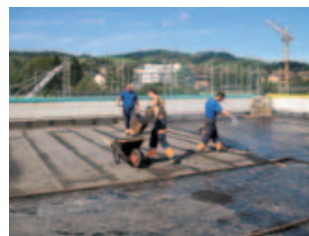
Bild 7: Gussasphalt als Schutzschicht.
