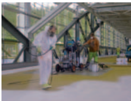
Stahltragplatte mit 2. Abdichtungsschicht im Spritzverfahren. Bei Stahl- oder Betonuntergrund lässt sich die Abdichtung einfach mit Tagesleistungen bis zu 1'500 m 2 pro Equipe applizieren.
