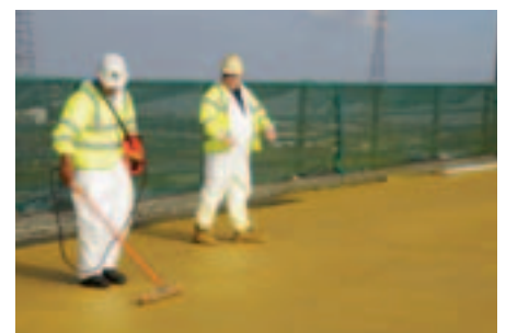
Abfunken der 1. Abdichtungsschicht.
