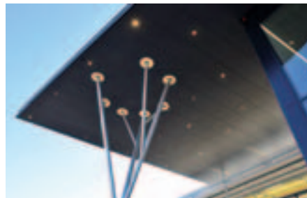
Bild 2: Markenzeichen im Eingangsbereich: die baumartige Stütze unter dem Vordach.
