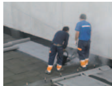
Bild 6: 1. Lage Abdichtung bei Rampe.
