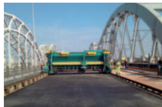
Einbauarbeiten auf der Darnetskij Brücke in Kiev.
