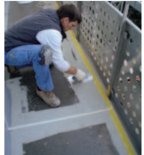
Rationeller Einbau: vollflächiger Auftrag der Abdichtungs- und Nutzschicht.
