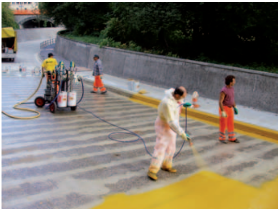
Betontraggrund mit 1. Abdichtungslage im Spritzverfahren.
