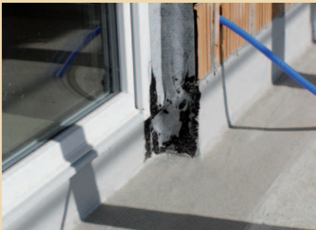
Mögliche Detaillösung: Flüssigkunststoffabdichtung über der Kragplatte mit Anschluss einer Wasserabweisfolie (dampfoffen, sd-Wert ca. 20 m).
