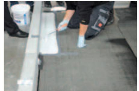
Abdichtungsdetail mit von Hand aufgetragenem Flüssigkunststoff für die flexible Ausgestaltung von Aufbordungen entlang Brücken.
