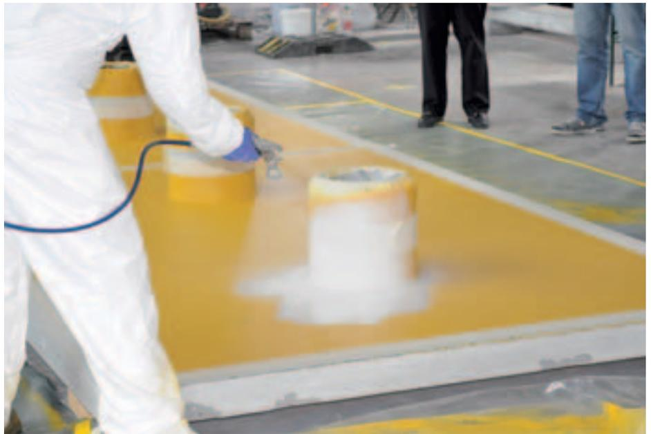
Aufspritzen von Flüssigkunststoff PMMA an Konsolenköpfen zwecks fugenloser Abdichtung von aufgehenden Bauteilen.
