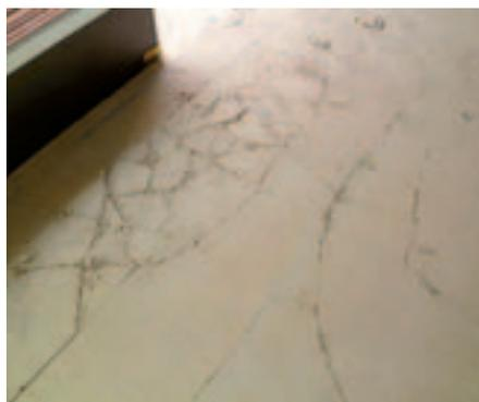
Schäden am Estrich durch übermässige Beanspruchung durch Lagergut.
