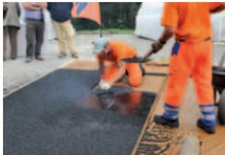
Abspalten einer von Hand eingebrachten Gussasphalt-Deckschicht mit vorumhüllten bituminiertem Splitt - in der Praxis auf der Baustelle mit feinen wie auch mit groben Gesteinskörnungen möglich.
