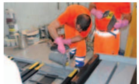
Verfüllen einer Joint-Fuge hautnah miterlebt: Fugenverguss live - die Besucherinnen und Besucher verfolgten die Konstruktion eines schwellenlosen und dauerhaften Belagübergangs.
