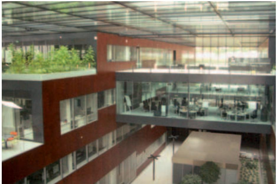
In dieser Mall eines Geschäftshauses können die defekten und absturzgefährdeten Deckenplatten wegen der fehlenden Bemessung des Estrichs nicht ersetzt werden. Der Estrich ist zu schwach, als dass er die Lasten der für die Arbeiten erforderlichen Hebebühne aufnehmen könnte. Die Mall musste teilweise gesperrt werden.
