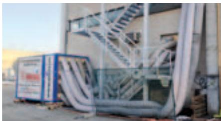
Unterdruckanlagen mit H13-Filter.
