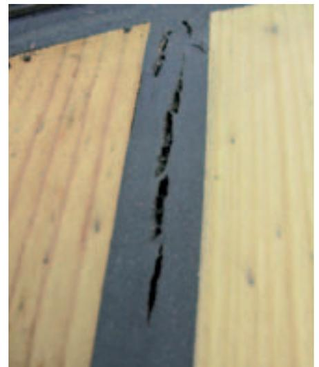
Bei Überdehnung einer Fuge reisst die Dichtungsmasse in sich selber...
