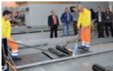
Korrektes Aufklammern einer Polymerbitumen-Dichtungsbahn zwecks Abdichtung einer vorbereiteten Betonunterlage - das verflüssigte Bitumen muss links und rechts der Schweissbahn entlang bis maximal 3 cm sichtbar ausfliessen, um eine dauerhafte Verklebung und Abdichtung zu garantieren.
