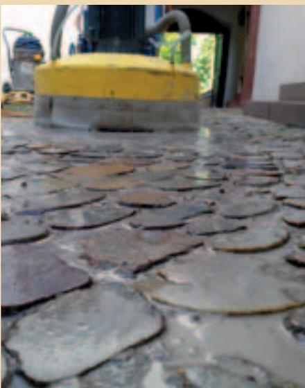
*Première opération de ponçage avec machine spéciale*
