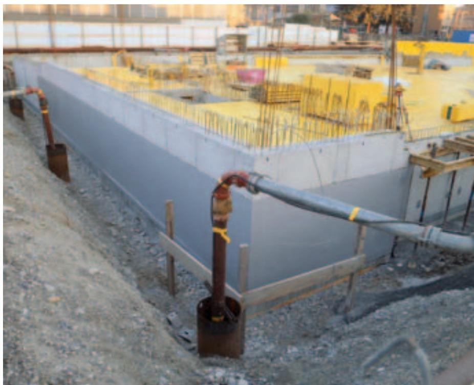
Flüssigkunststoff-Flächenabdichtung im Bereich unter Terrain
