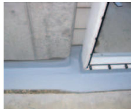
Schwellenanschluss mit Flüssigkunststoffabdichtung
