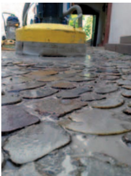
Erster Schleifvorgang mit Spezialmaschine.
