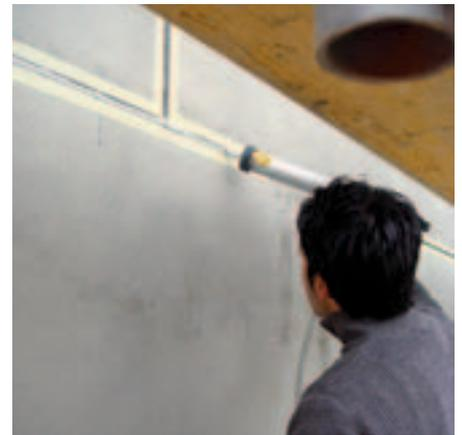
Nach systemgerechter Ausbildung der Fuge wird sie mit Dichtstoff abgedichtet.
