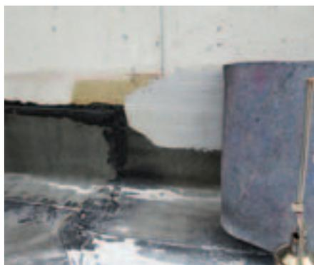
Abdichtungsanschluss an Betonwand bei einer PBD-Bahn Aufbordung.
