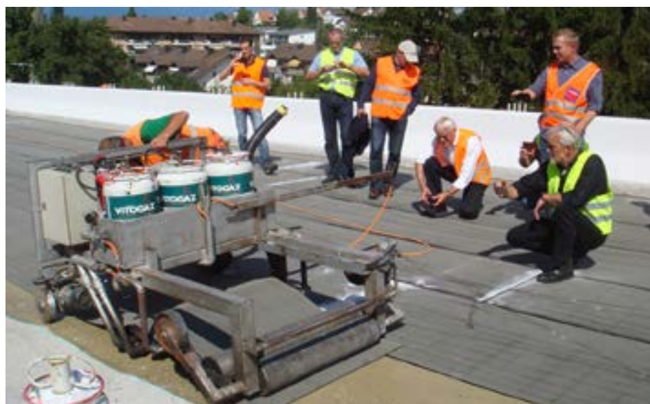
Einbau von PBD Bahnen maschinell. Pose de lés PBD à l'aide d'une machine.
