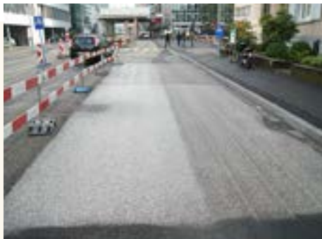
La surface à gauche est traitée à l'aide du système Divico Kleweg, à droite traitement par microbillage.
