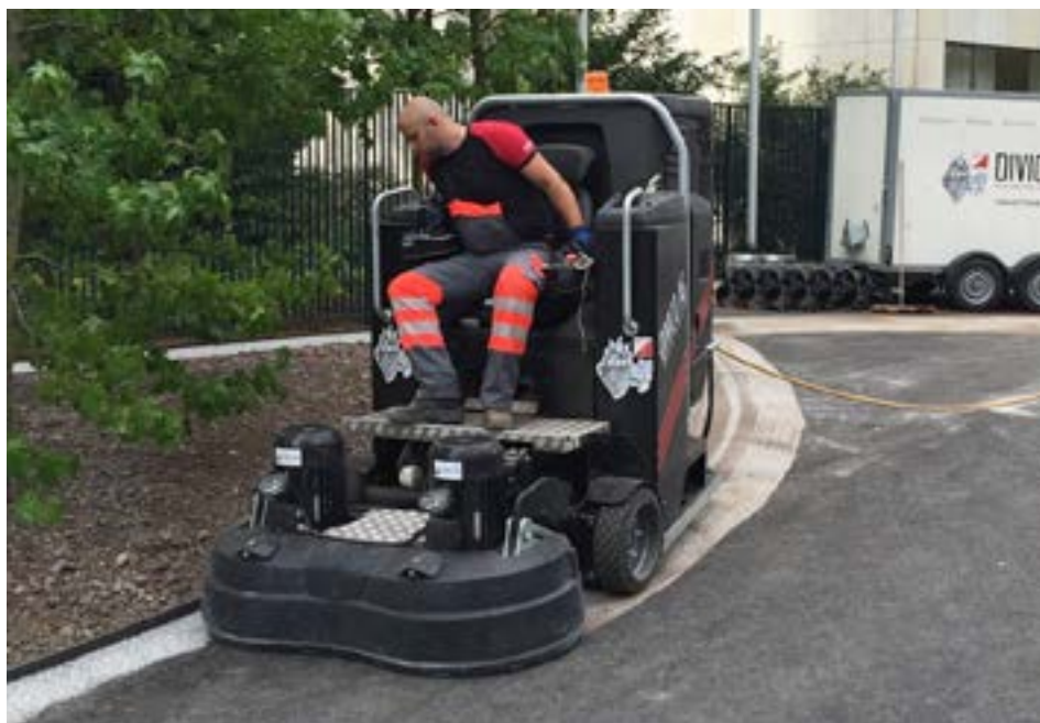
Oberflächenbearbeitung von Asphalt- und Betonbelägen mit dem System Divico Kleweg. Traitement de surface de revêtements en asphalte et béton à l'aide du système Divico Kleweg.
