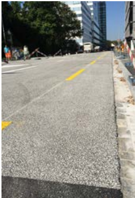
Grenzacherstrasse in Basel nach Aufbringung der Markierungen. Grenzacherstrasse à Bâle après application du marquage au sol.
