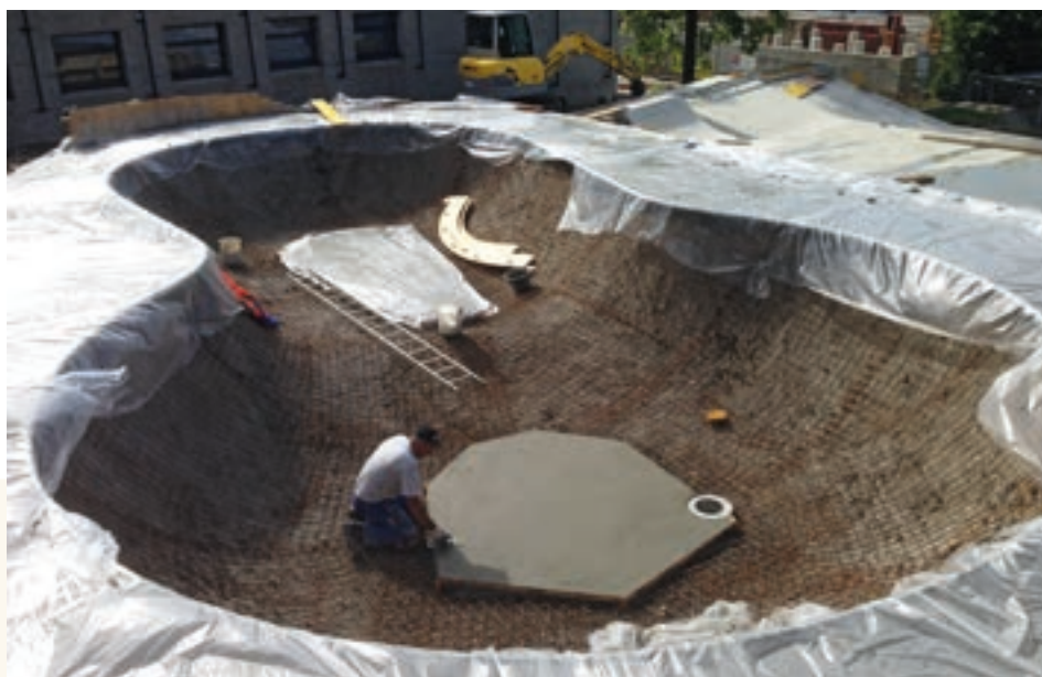
Glätten der Sohle in der «bowl». Lissage du radier dans le «bowl».
