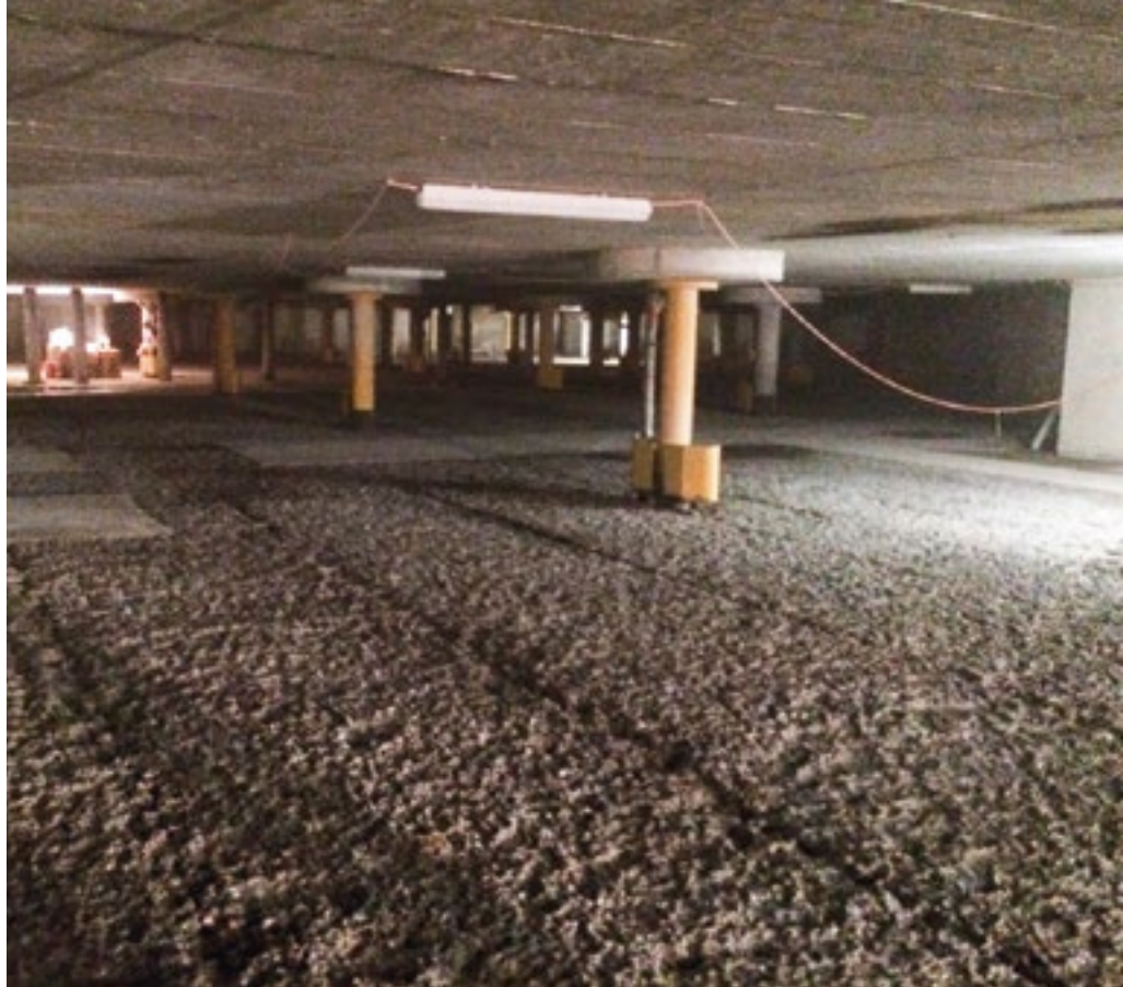
Vorbereiteter Untergrund für die Instandsetzung.
