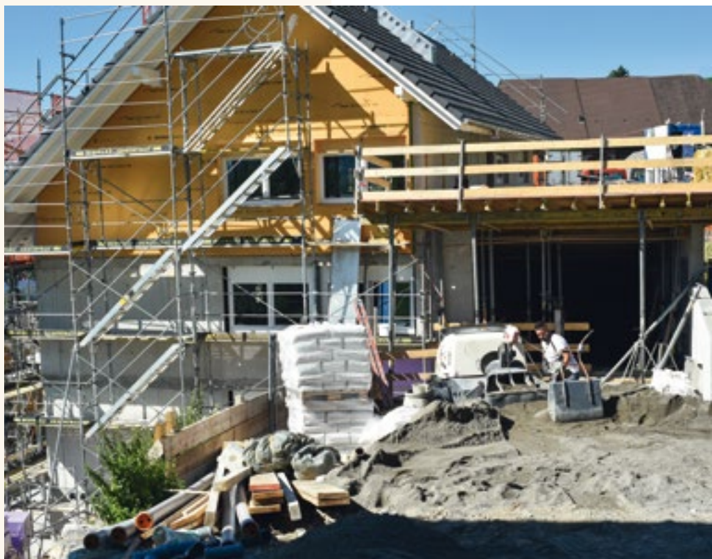
Site d'installation pour des chapes conventionnelles
