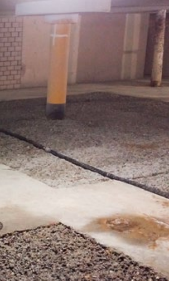
Support prêt pour la rénovation. >
