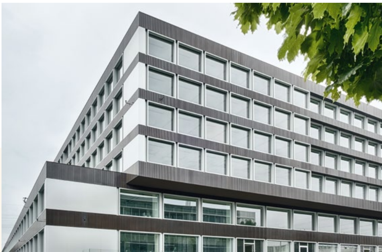
Le centre d'affaires moderne après la rénovation totale.
