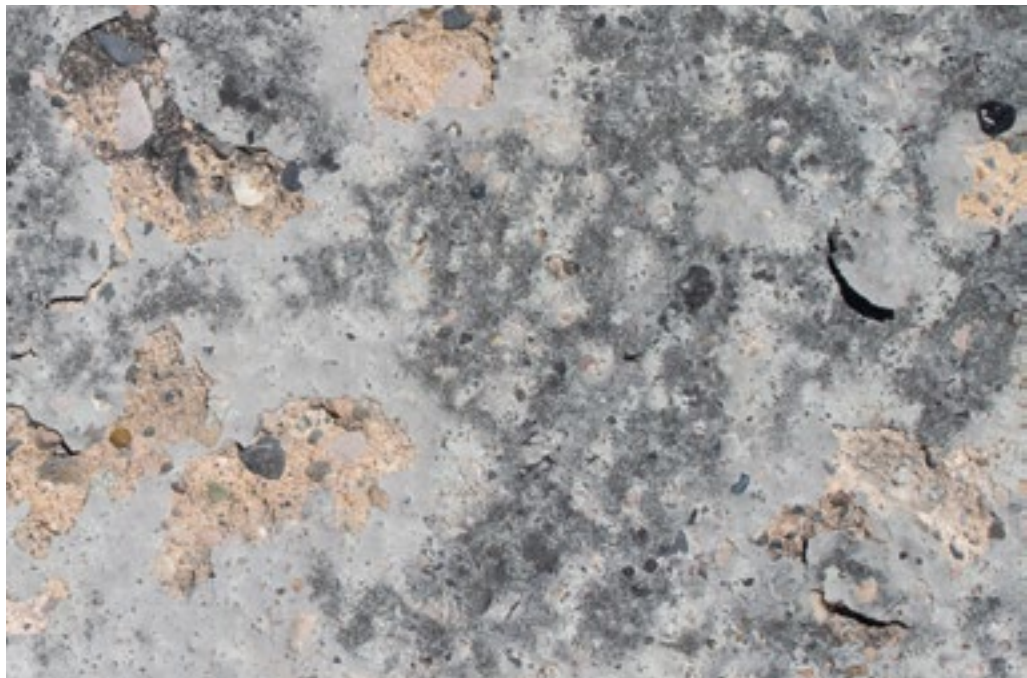
Die Zementhaut auf der Betonoberfläche muss entfernt werden.
