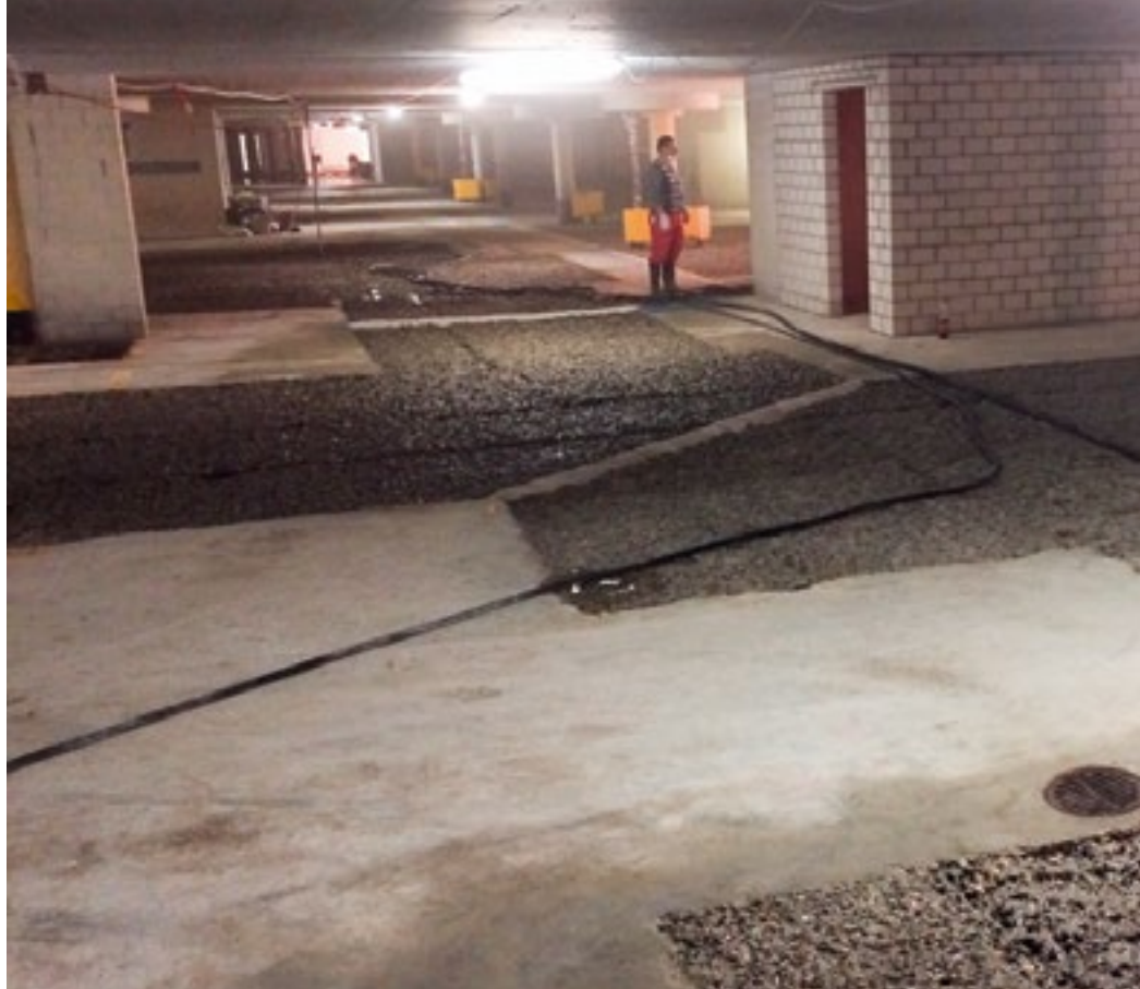
Pour les 29 000 m 2 , 1400 tonnes de mortier de rénovation ont été appliquées.
