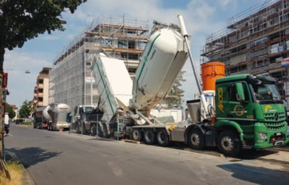
Encombrement pour la pose des chapes liquides aux chantiers plus grands.
