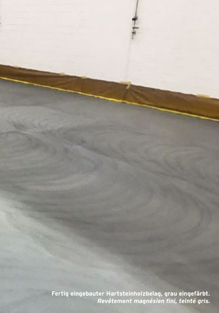
Fertig eingebauter, grauer Hartsteinholzbelag. Revêtement magnésien fini, gris.
