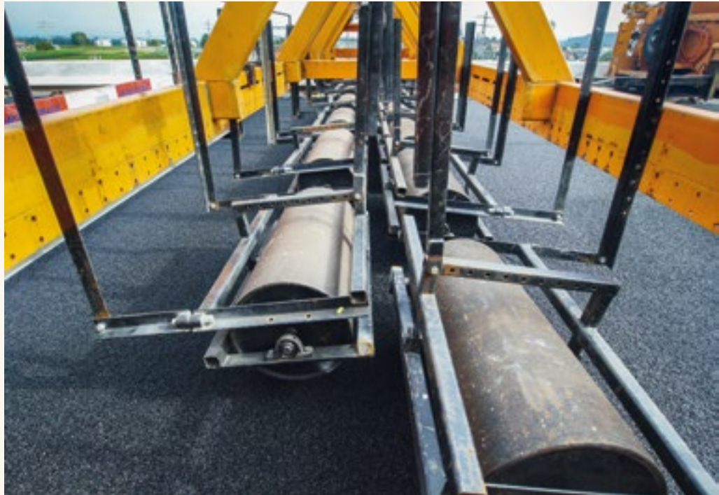
Compacter - passer le rouleau compresseur.
