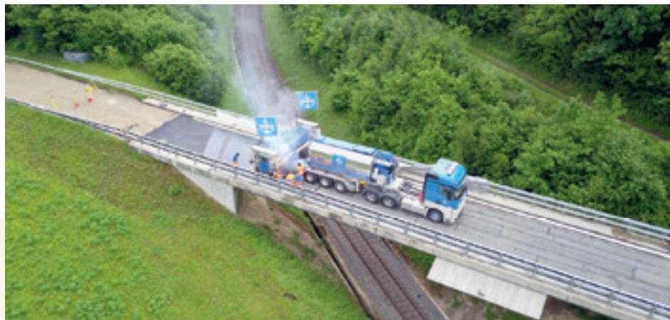
La nouvelle table de pose d'asphalte coulé avec commande intelligente de la machine en 3D.
