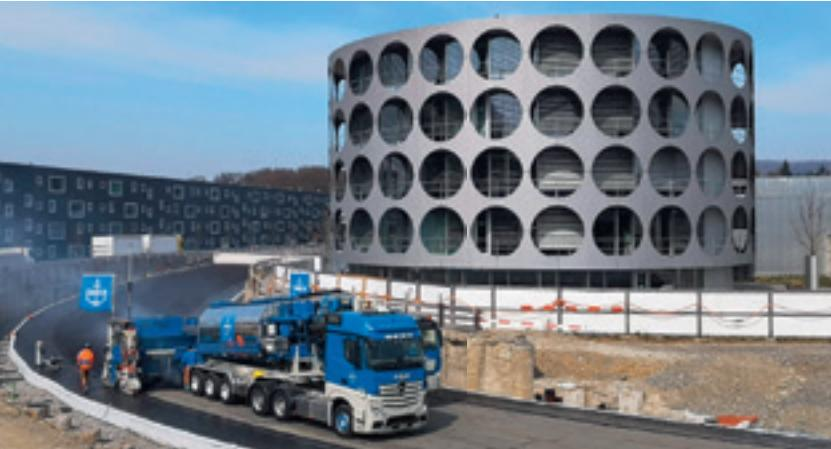
Pose à guidage 3D à Lenzburg, où l'on a posé 1200m<sup>2</sup> d'asphalte coulé.
