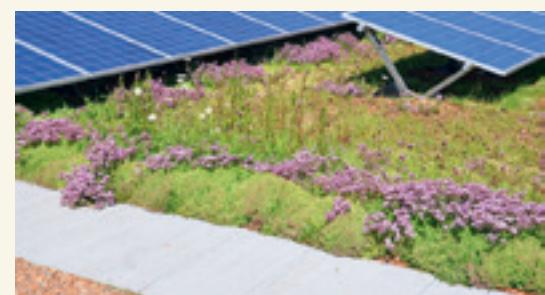
Système de surélévation pour toit végétalisé énergétique: une végétation basse et des modules surélevés empêchent des ombrages. La plaque de fond de ce système sert à la fois de réservoir d'eau, de support du substrat et de fixation résistante au vent du système sans avoir à traverser la toiture. (© Contec AG)
