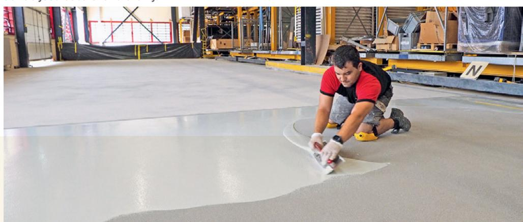
*Pose de la couche d'usure en résine époxy Sikafloor-390 du système MultiDur EB-39 sur la couche de fond saupoudrée.*
