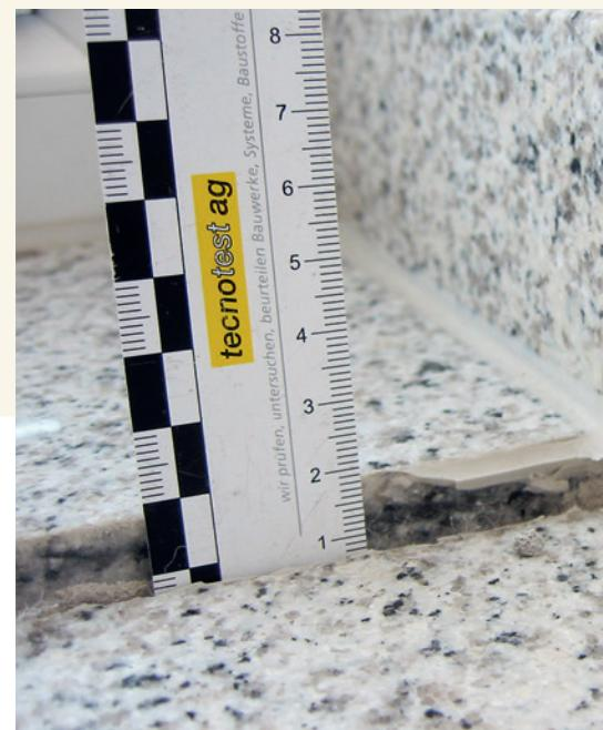
**Abb. 4: Absenken des Natursteinbelags und Ablösen der Fugendichtungsmasse.**
