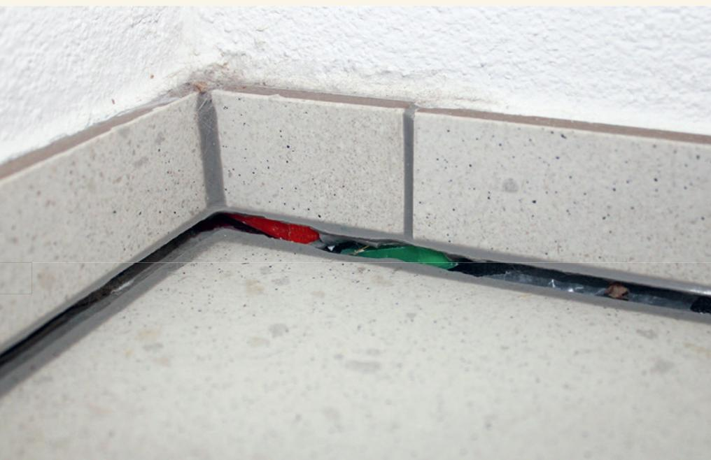
**Abb. 3: Absenken des Bodenbelags vom Wandsockel.**
