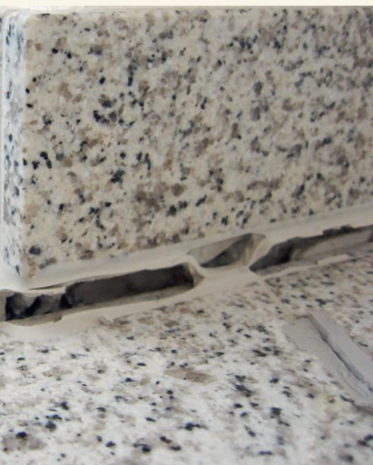
**Fig. 5: Décollement de la plaque de socle solidement fixée à la masse d'étanchéité des joints lors de l'abaissement de la chape.**
