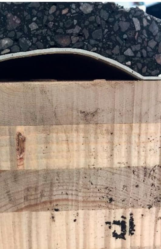
*Figure 1: vue en coupe d'une cloque entre l'étanchéité PMMA et le support en bois.*
