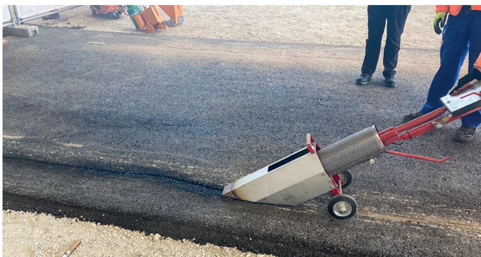
Rissverguss: Fachkurs bituminöse Fugenmassen in Verkehrsflächen.
