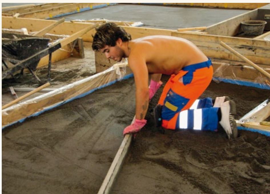
Estrich Einbau in der Lehrhalle in Sursee.
