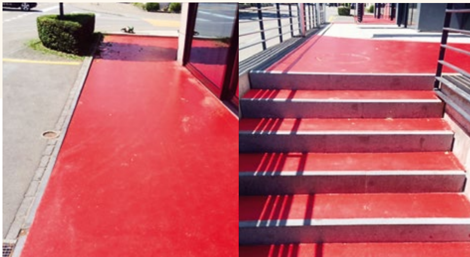
Polyurethanbeschichtung bei der Raiffeisenbank in Tägerwilen
