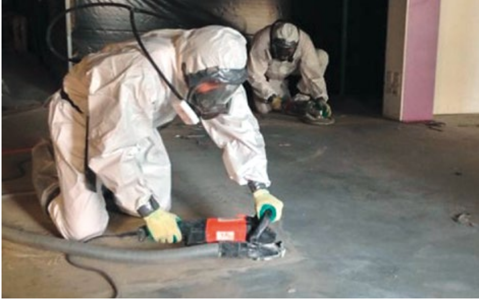
Asbestsanierung von Bodenbelägen
