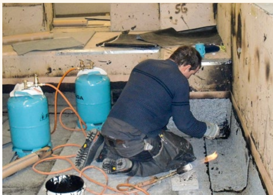
Eckausbildung mit PBD-Abdichtung an der Maquette.
