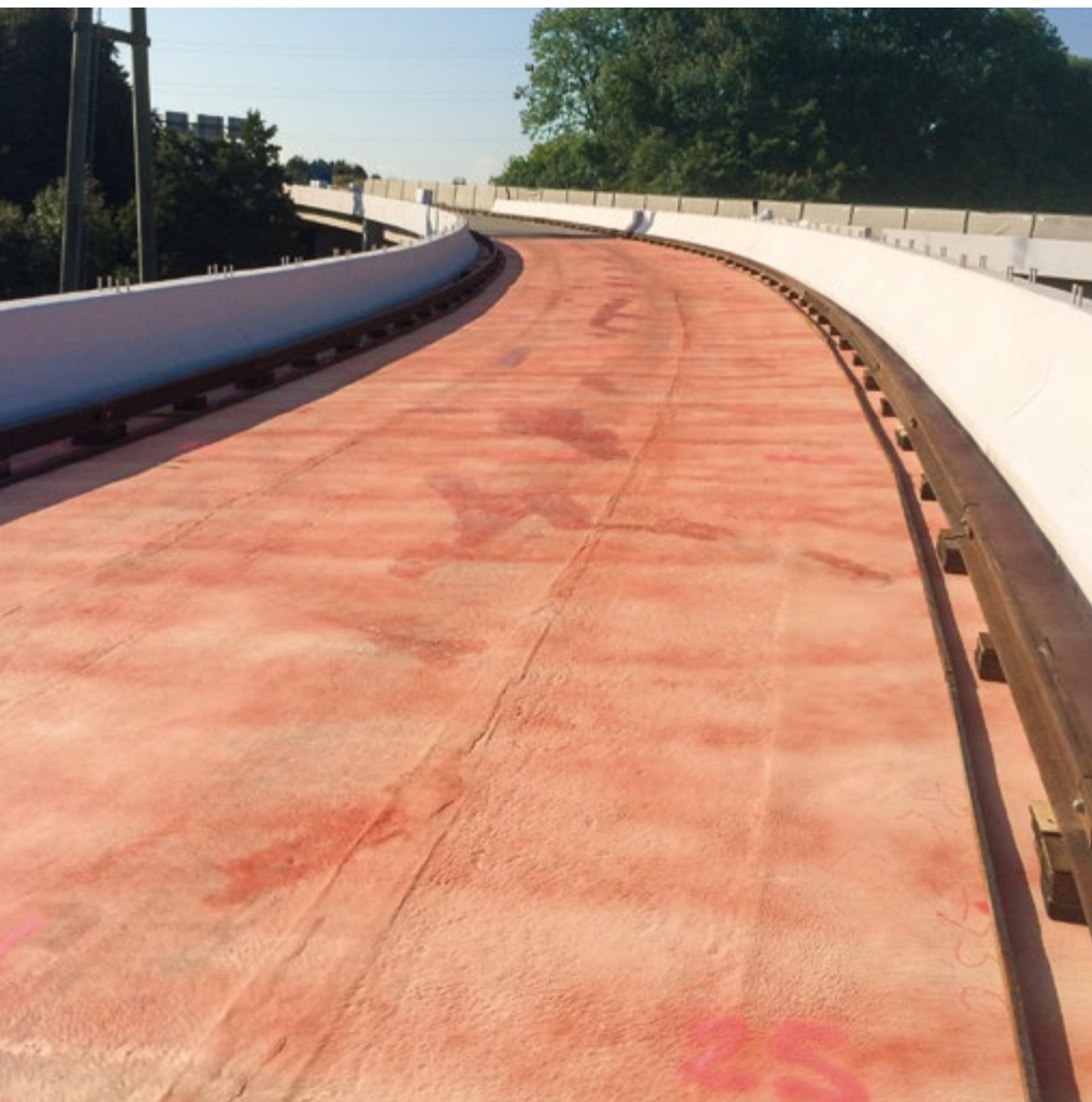
Abdichtung der Fläche mit Flüssigkunststoff.
