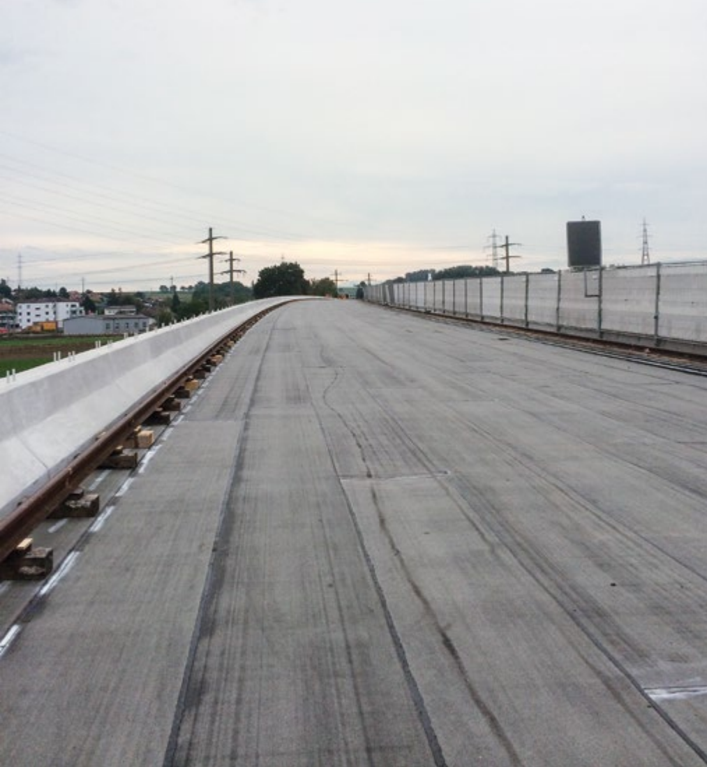
Abdichten der Flächen mit PBD-Bahnen.
