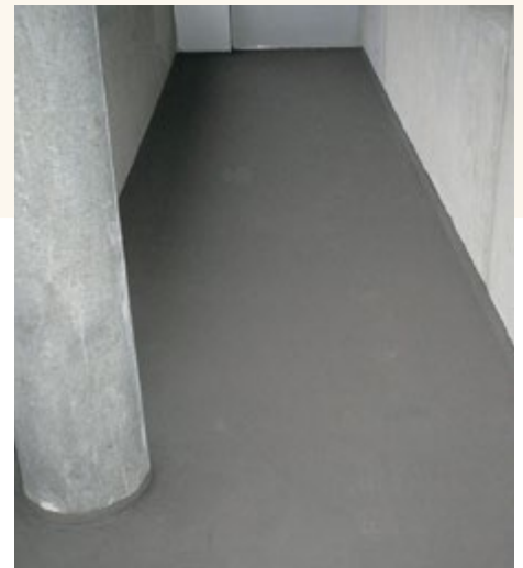
Acryldispersion-Beschichtung in der Binzmühle in Zürich.
