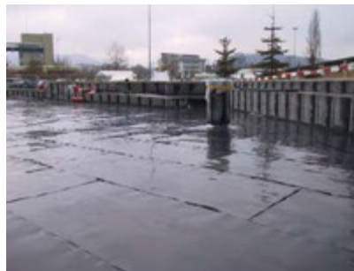
Befahrbare Schutzplatte auf Horizontalflächen Schichtdicke 2–10 mm
