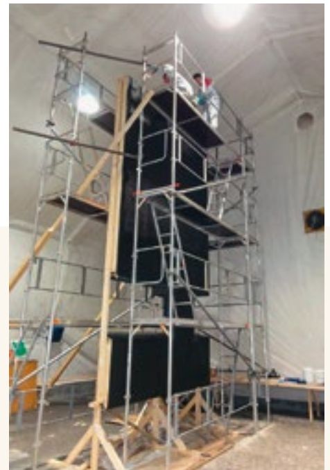
Essai échelle 1:1: revêtement sur maquette de façade dans le hall de fabrication.
