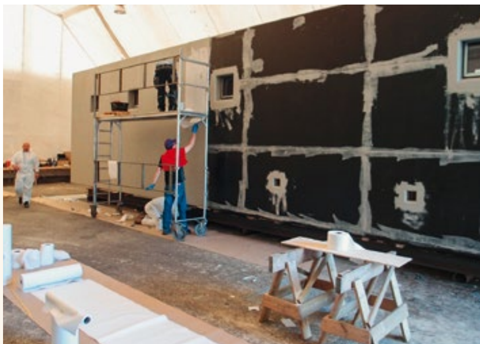
Aufbringen der Abdichtung in der Fertigungshalle (links im weissen Overall: Malermeister Tor Meusburger, in der Mitte mit rotem Pullover Martin Kiefer und mit schwarzer Hose Felix Kolbe).
