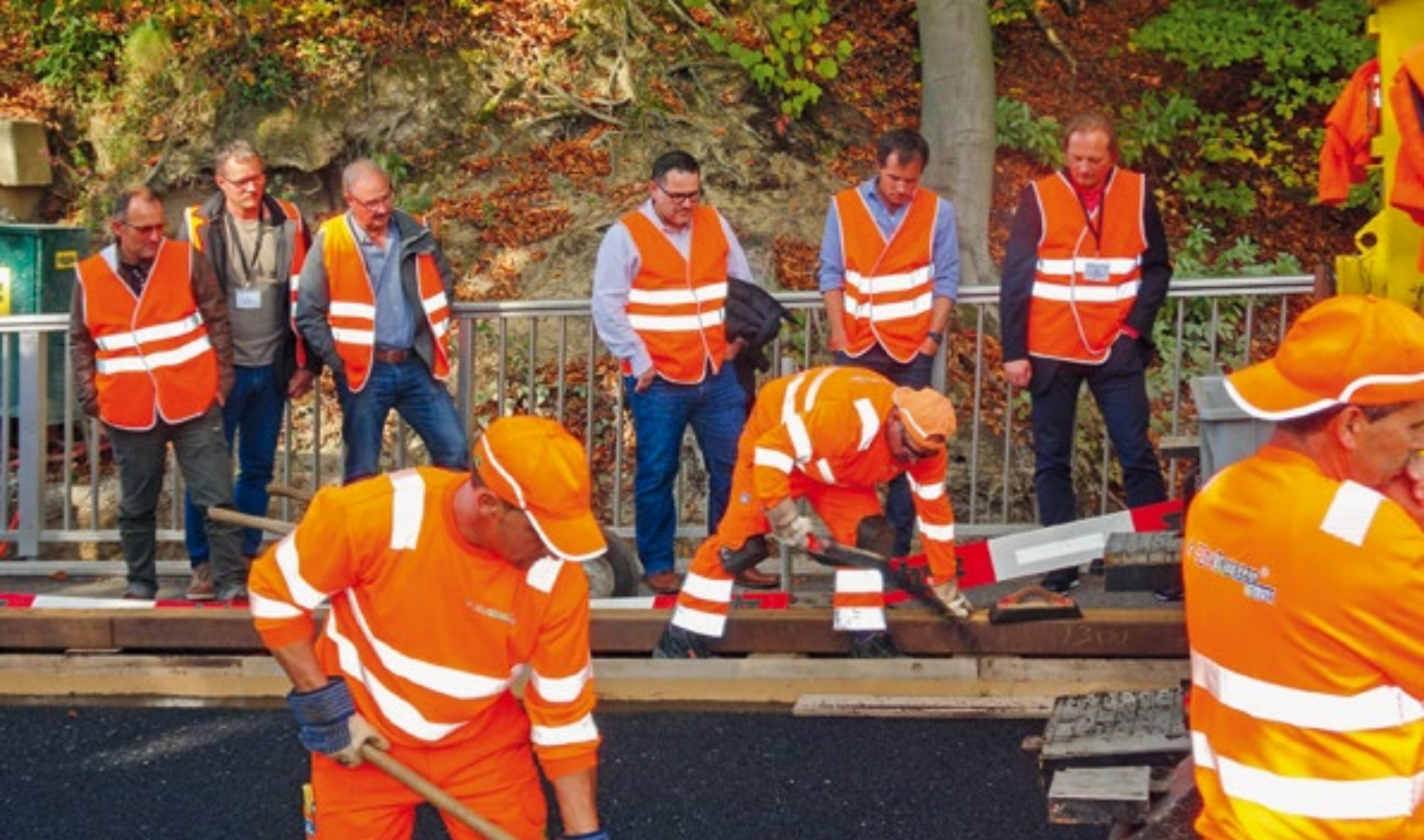
Besichtigung des Gussasphalt-Einbaus auf einer Brücke bei Luzern.
