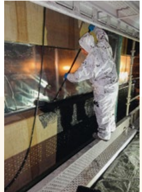
Application au chantier de la couche de contrôle sur la jute posée.
