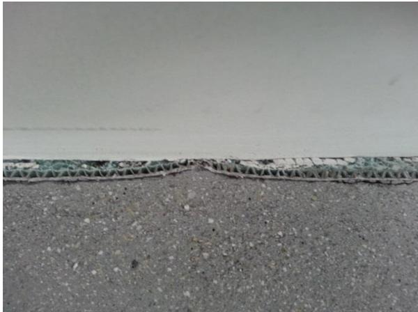
Verheerend: Randstreifen mit Heftklammern befestigt. Das wird Risse geben! (Siehe Empfehlung PAV-E 20 «Randstreifen bei Estrichen»).
