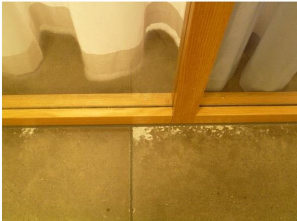
Aufsteigende Feuchtigkeit aus der Fuge eines nicht vollständig verlegereifen Fliesenestrichs.
