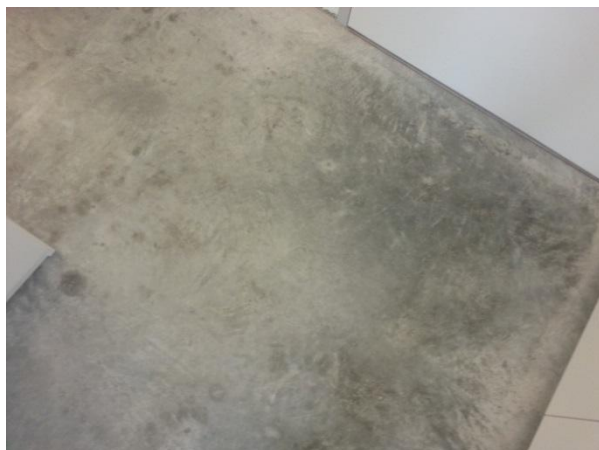
Ungleichmässiges Abdecken ist immer problematisch. Das Terminprogramm muss so festgelegt werden, dass die Flächen unbedeckt trocknen können.
