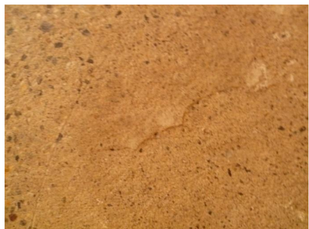
Einsatz von falschem Schleifwerkzeug. Klar beanstandenswert.
