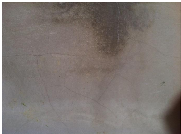
Vereinzelte Haarrisse bei Verbundkonstruktionen bis zu einer Rissbreite von 0.1 mm müssen akzeptiert werden können.
