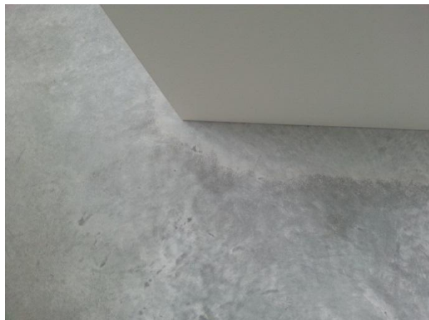
Ungleichmässiges Abdecken ist immer problematisch. Das Terminprogramm muss so festgelegt werden, dass die Flächen unbedeckt trocknen können.
