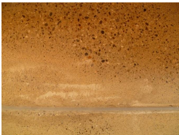
Ungenügendes Schleifen neben der Fuge. Das darf nicht sein und ist eine berechnete Beanstandung.
