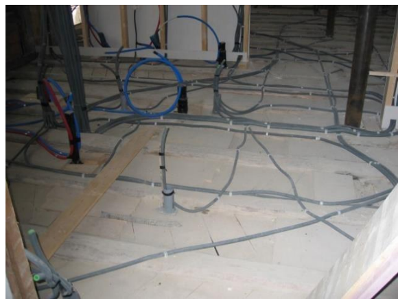
Neu- oder Umbau mit vielen Installationen
