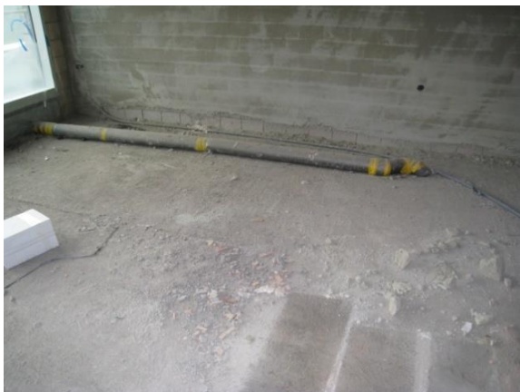
Neu- oder Umbau mit Nachinstallationen
