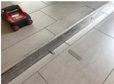
**Abbildung 2:** Einsenkung im mittleren Drittel der Estrichfläche ca. 7mm. Im Plattenbelag ist die Einsenkung im Streiflicht zu erkennen. Die auf Druck beanspruchten Plattenoberflächen sind jedoch (noch) nicht gerissen.
