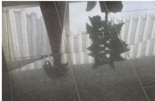
**Abbildung 2:** Einsenkung mit Riss im Natursteinplattenbelag im mittleren Drittel der Estrichfläche. Der Riss erscheint im Streiflicht über einer leichten Einsenkung. Die durch Druck beanspruchte Oberfläche der Natursteinplatte schiefert auf.
