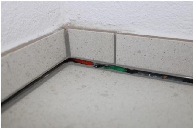
Abbildung 1: Ablösen des Bodenbelags vom Wandsockel.
