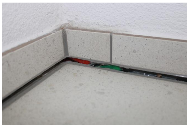
Abbildung 1: Ablösen des Bodenbelags vom Wandsockel.
