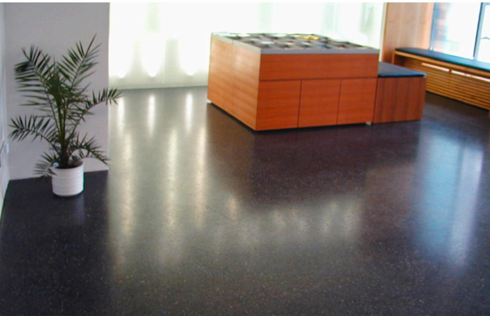
Gussasphalt spricht den Menschen an. Die gestalterischen Möglichkeiten in Verbindung mit den technischen Vorzügen machen Gussasphalt zu einem exklusiven, modernen Baustoff. Gussasphalt ist aber auch ein zeitloser Baustoff und wird bereits seit über 5000 Jahren am Bau eingesetzt. Die Bezeichnung Asphalt lässt sich auf den griechischen Begriff «ασφαλτης» (aspales= sicher, zuverlässig, dauerhaft) zurückführen, während die Römer von einem «pix tumens» (Erdpech) sprachen.
