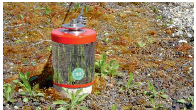
Abb. 25: Objektspezifische Anlagebeschriftung mit Prüfvignette
