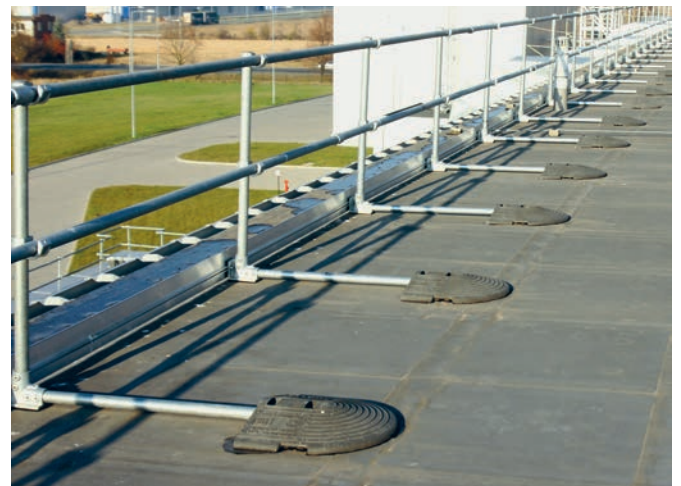
Abb. 16: Ausstattungsstufe 3: Seitenschutzsystem mit Auflast
