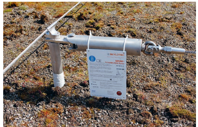
Abb. 24: Objektspezifische Anlagebeschriftung
