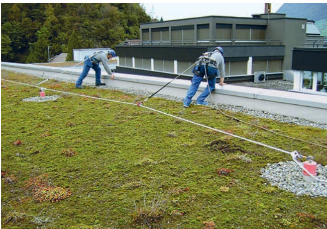
Abb. 10: Temporäres Seilsystem mit Karabinerhaken an EAP befestigt
