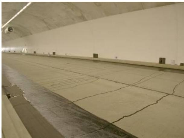
*Nach Abtragung der nicht festen Schicht zeigte sich dieses Rissbild. Die Sanierung der Risse erfolgte mit Elastomerbitumen.*
