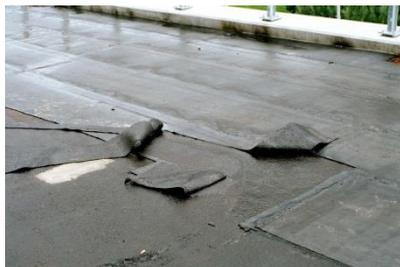
*Abbildung 1: PBD-Abdichtung mit sehr schwachem Verbund. Direkt nach dem Aufvlämmen war der Verbund gut, am nächsten Tag jedoch völlig ungenügend.*
