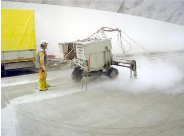
*Hier musste mit gröberem Geschütz aufgefahren werden: Wasser-Hochdruckstrahlen mit 2000 bar, Abtragung 2-3 mm.*
