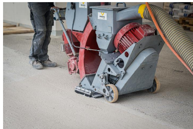
Kugelstrahlarbeiten in Innenräumen.
