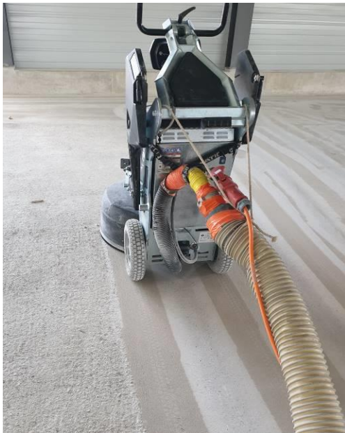
Verminderung der Rautiefe des nicht taloschierten Betons.
