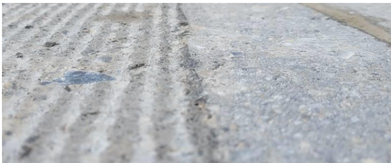
Links: gefräster Beton / Rechts: Verminderte Rautiefe. Verminderung der Rautiefe auf gefrästem Beton. Die Rautiefe wird mittels Schleifen von ca. 4,9 mm auf < 1mm verringert.
