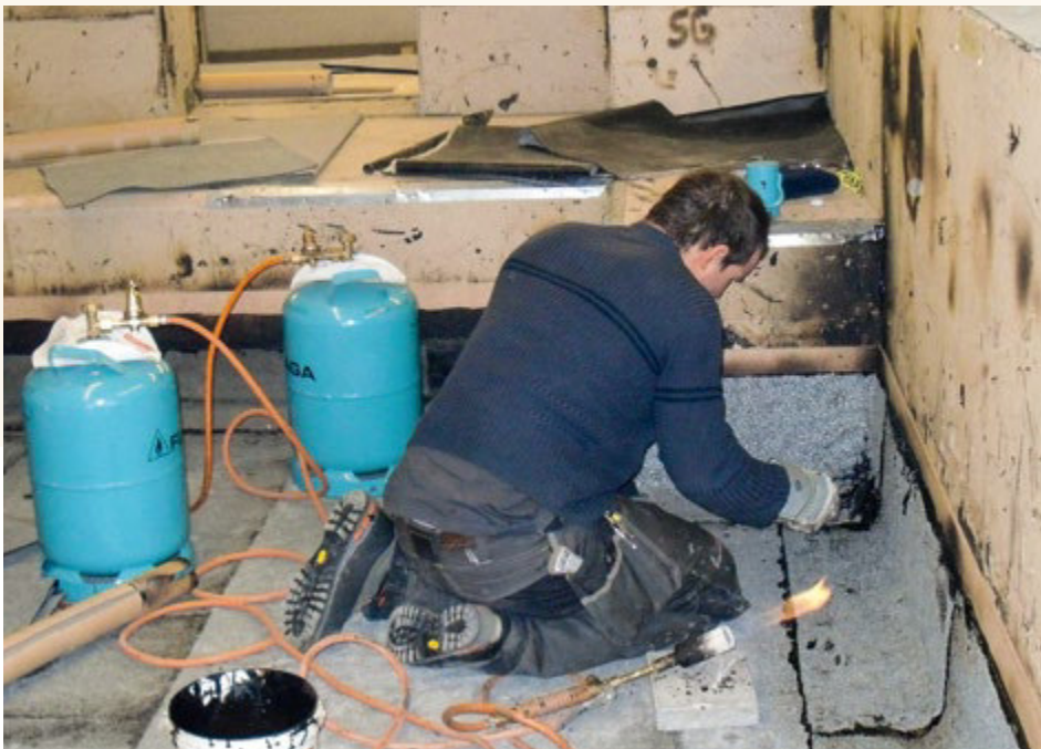
Eckausbildung mit PBD-Abdichtung an der Maquette.
