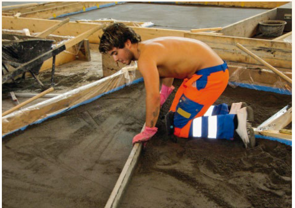
Estrich Einbau in der Lehrhalle in Sursee.
