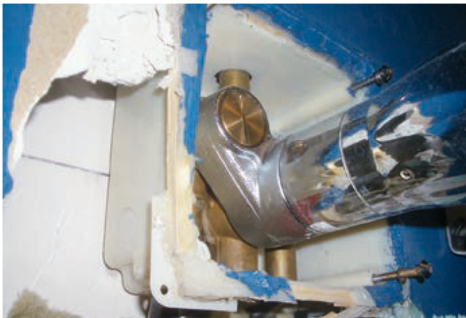
Sanitäranlagen durchdringen in Duschen die Abdichtungsschicht der Wände und müssen mit Hilfe von Dichtmanschetten in die Abdichtungsebene eingebettet werden.
