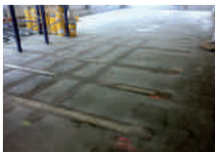
Die Schlitzte mit eingeklebten Lamellen und mit Epoxydharzmörtel verfüllt.
