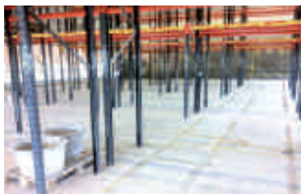
Sanierung durch konstruktive Verstärkung der Böden während laufendem Betrieb.
