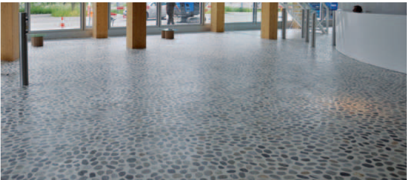
«Im Fluss» - Der Terrazzobodenbelag mit Flusssteinen kontrastiert ästhetisch ansprechend die hölzerne Tragstruktur.
