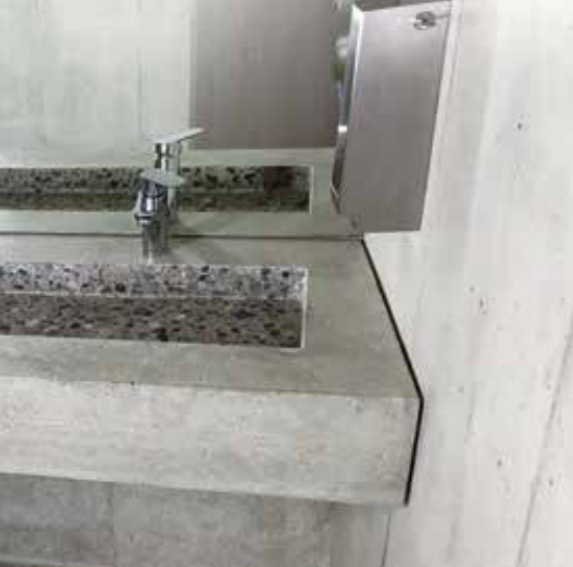
Wasch-Becken in Ortbeton
