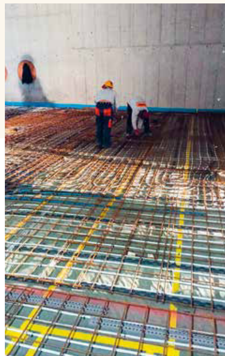
Armierung mit Lagermatten Z558 auf Distanzhaltern
