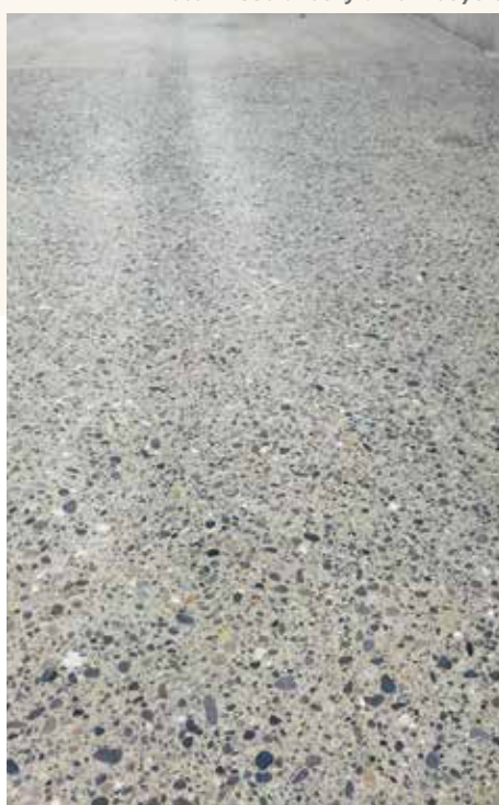
Geschliffener Beton mit Recycling-Kies
