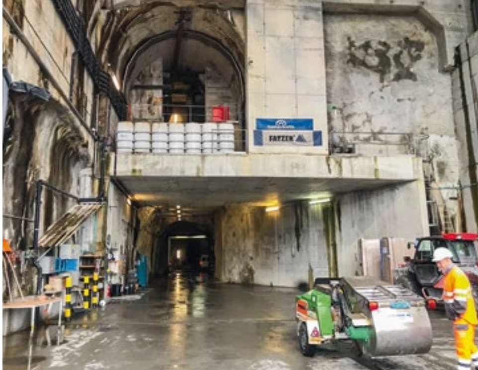
Bergstation und Umschlagplatz im Fels. Im Hintergrund Zufahrtsstollen zur Maschinenhalle.
