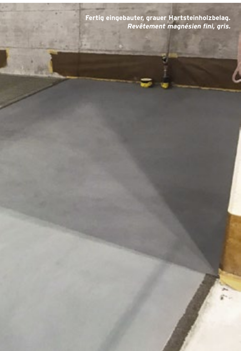
Fertig eingebauter Hartsteinholzbelag, grau eingefärbt. Revêtement magnésien fini, teinté gris.
