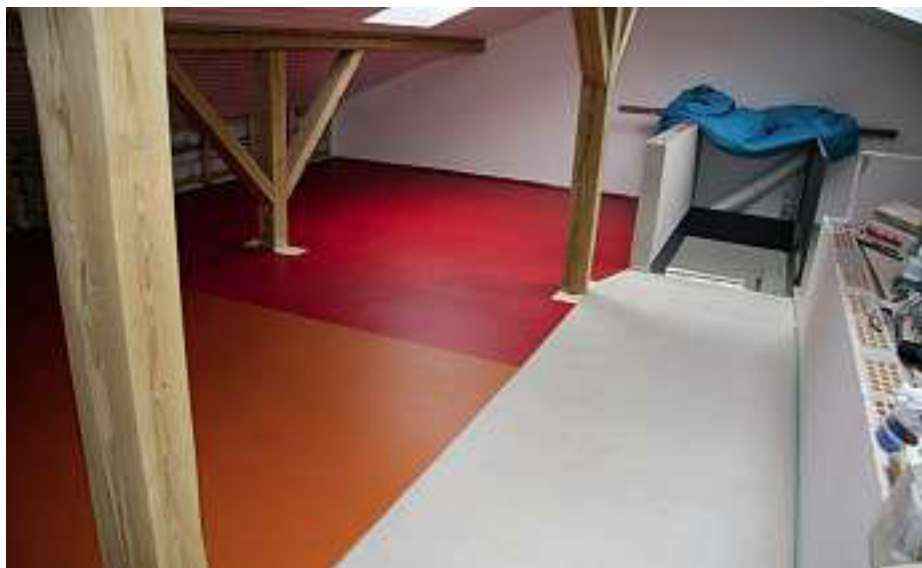
Anhydrit-Fliessestriche (CAF) werden vermehrt als Sichtestriche verwendet und dienen als End- und Nutzbelag.
