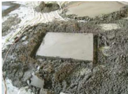
Korrekt hergestellte Probefläche in der erforderlichen Dicke.
