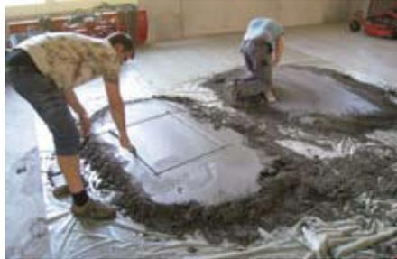
Die Probefläche wird z.B. mit dem Fugeneisen markiert und «ausgeschnitten».
