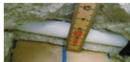
Die vertikale Abweichung beträgt mit 15 mm ca. 300% des nach Norm tolerierbaren Masses.
