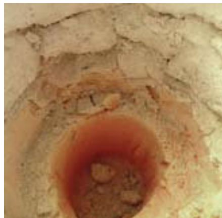
Ein Fliessenestrich darf bei der Materialentnahme mit der Bohrkernmaschine nicht zerfallen.
